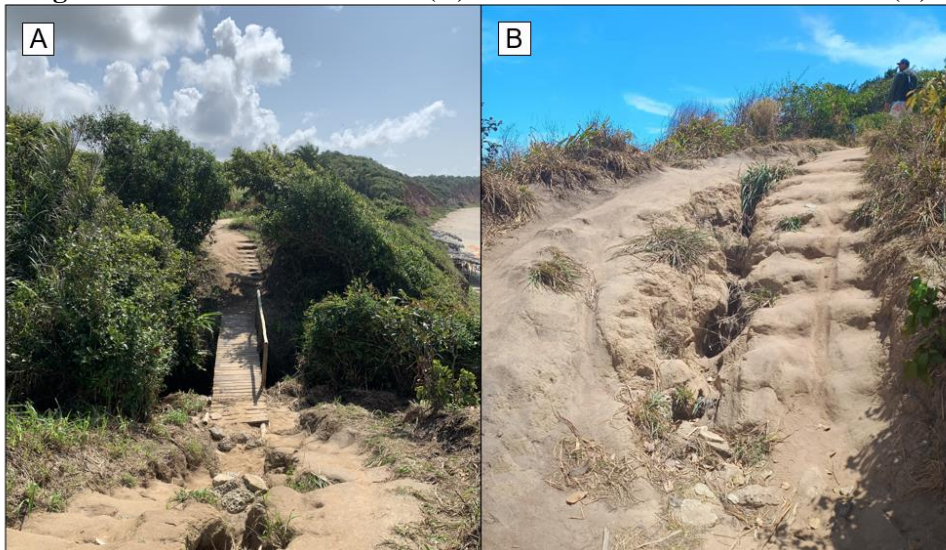
Figura 26 - Estrutura de acesso (A) e ravinamento em acesso à Praia (B).
