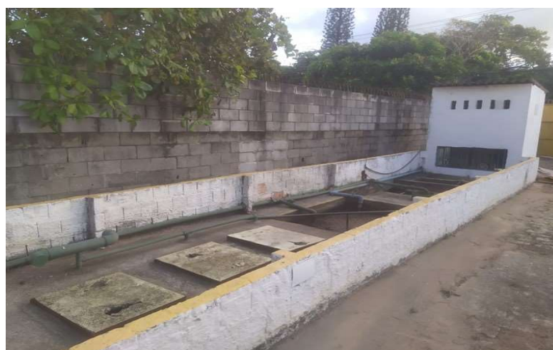
Figura 5.4. Vista geral da ETE 1 Fonte: a autora (2022)
