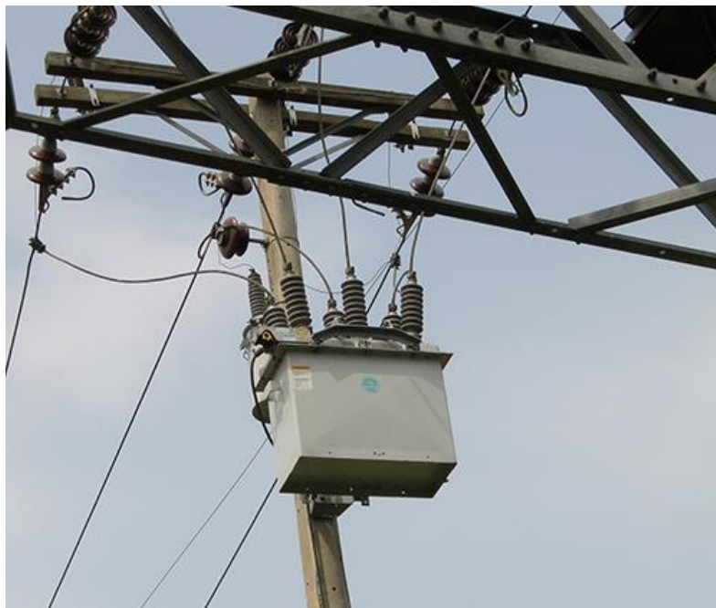
Figura 8 – Religador trifásico de distribuição.
