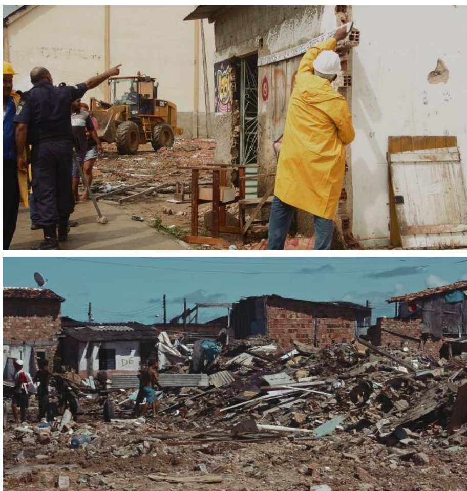
Figura 38 – Sequência 10 – Demolição da favela sururu de capote
