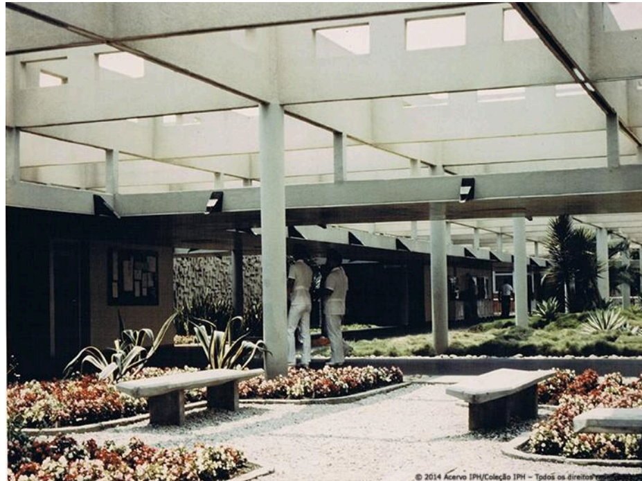
Imagem 03 - Eixo de Circulação Externa, Hospital da Guarnição do Galeão.
