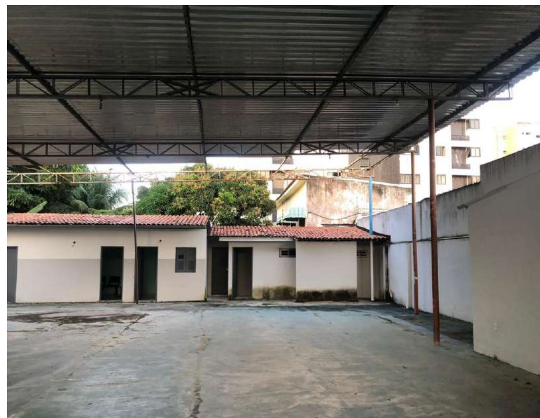
Figura 23 – Foto da quadra com pilares oxidados e parte da estrutura sustentada por um pilar de madeira.
