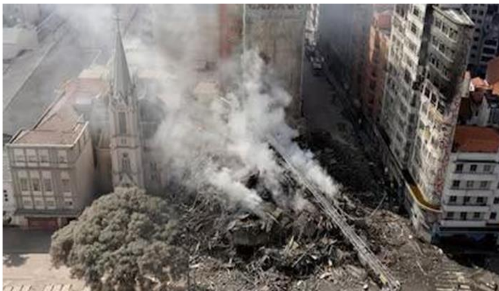
Figura 1: Edifício Wilton Paes de Almeida após colapso de sua estrutura
