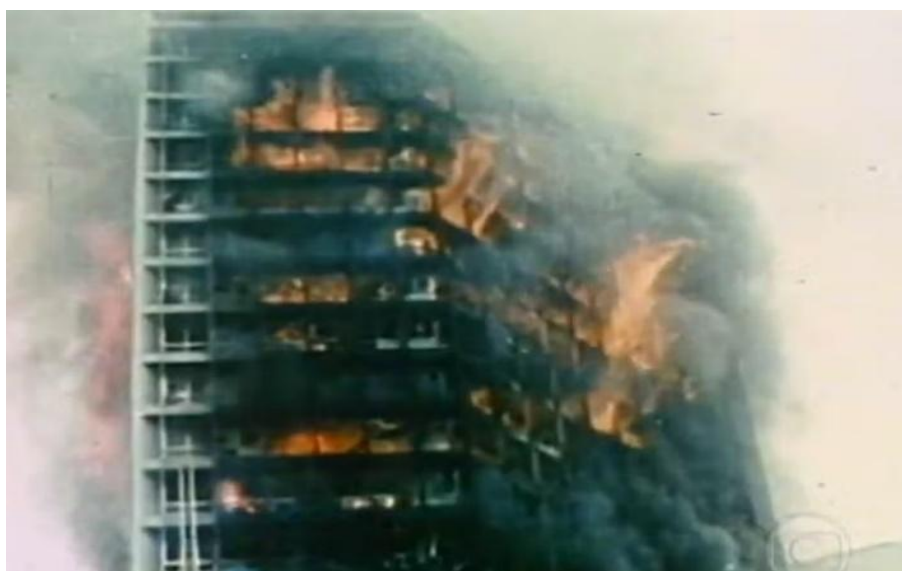
Figura 2: Edifício Joelma em chamas.
