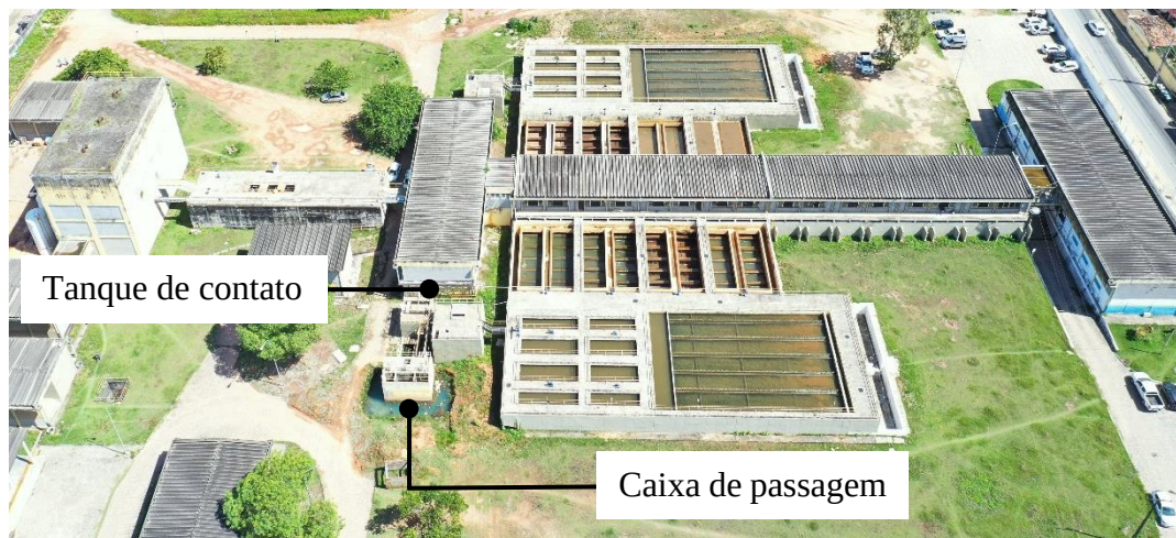
Figura 14 – vista aérea da ETA Josué Palmeira com a localização do tanque de contato e da caixa de passagem de saída de água tratada
