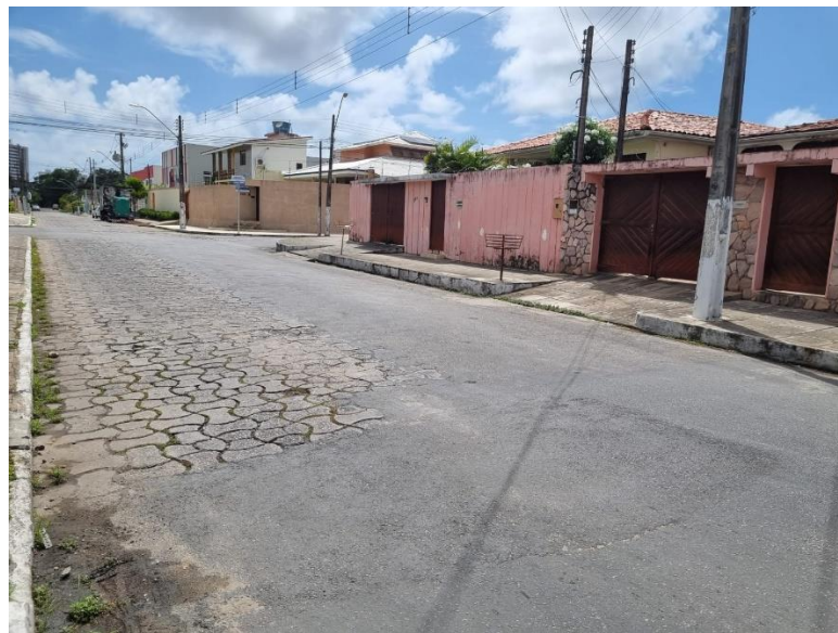
Figura 14: Transição de pavimento asfáltico para intertravado.
