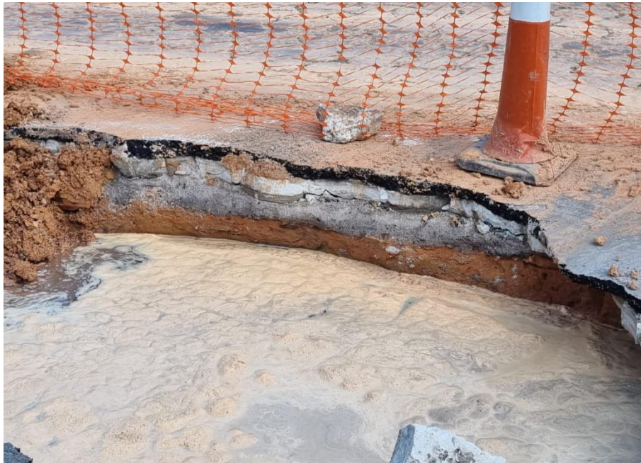
Figura 19: Camadas do pavimento.
