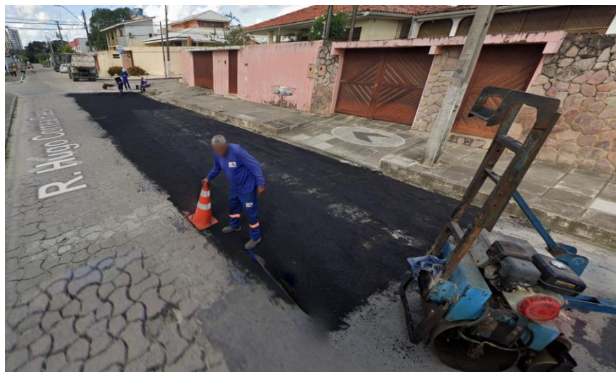
Figura 11: Execução de pavimento asfáltico no trecho de transição entre pavimentação asfáltica e intertravado da via estudada.
