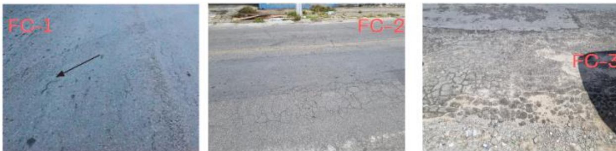
Figura 4: Tipos de fenda
