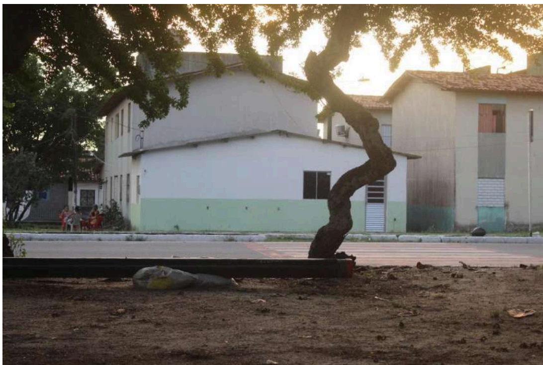
Figura 19: Anexo construído ao lado da habitação, no conjunto Vila São Pedro.
