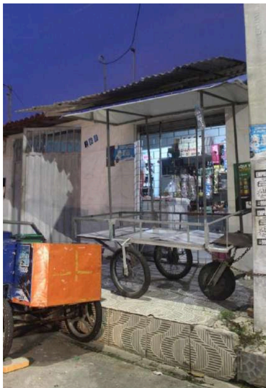
Figura 09: Comércio dentro da habitação com sacrifício de um cômodo e utilização de espaço público no conjunto Joaquim Leão.
