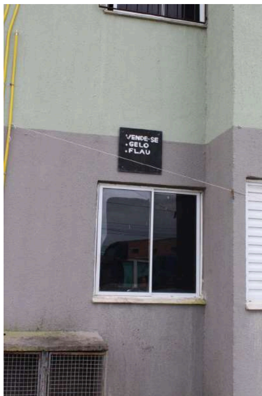
Figura 21: Placa ou pintura na fachada da habitação, no Residencial Parque da Lagoa.
