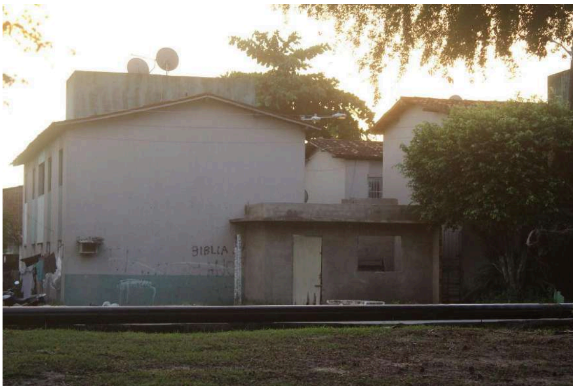
Figura 18: Anexo construído ao lado da habitação, no conjunto Vila São Pedro.
