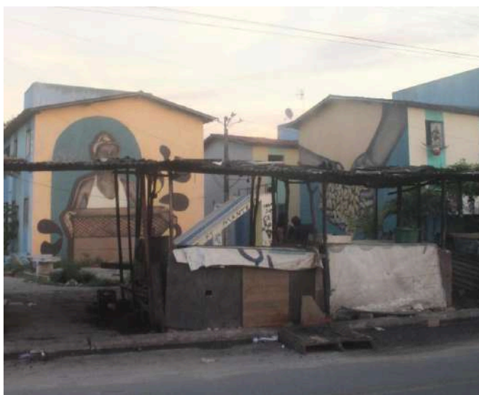
Figura 15: Anexos construídos na área de passeio público no conjunto Vila São Pedro.
