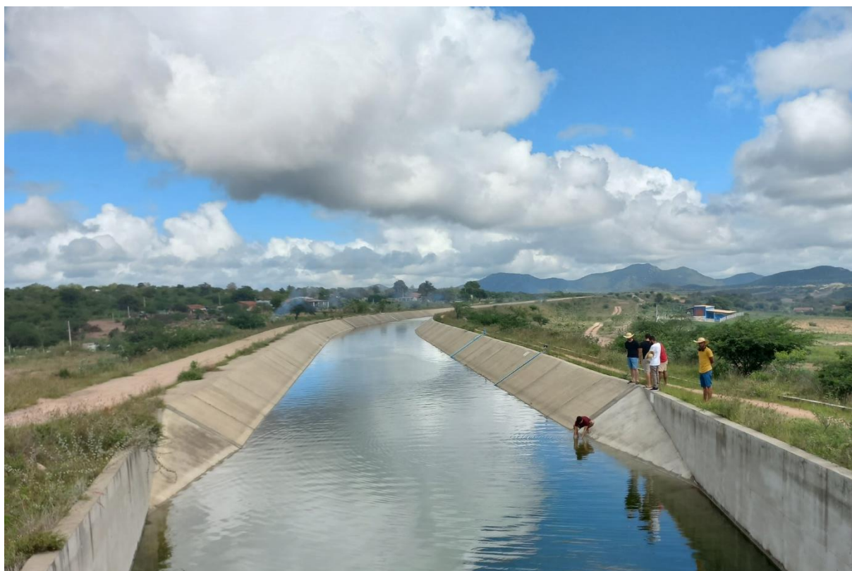
Figura 4. Parte do Canal do Sertão já construído no município de São José da Tapera (Ano: 2023). Fonte: Autores
