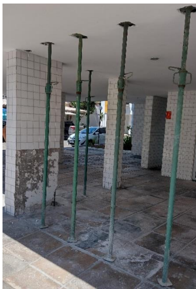
Figura 18 – Escora dos pilares
