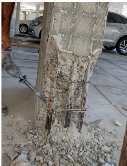
Figura 19 – Quebra dos pilares com furadeira martetele
