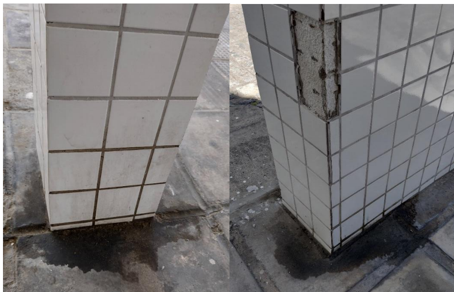
Figura 20 – Pilares com incidência de urina
