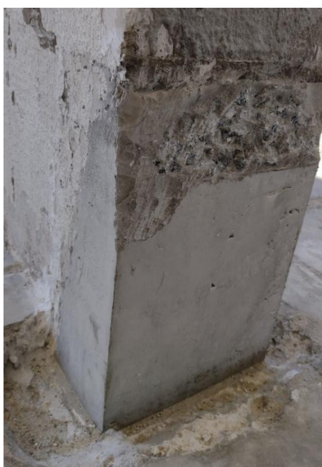
Figura 39 – Pilar restaurado com graute
