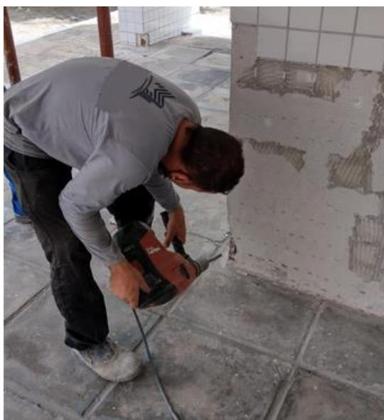
Figura 33 – Quebra da base dos pilares com furadeira martelete
