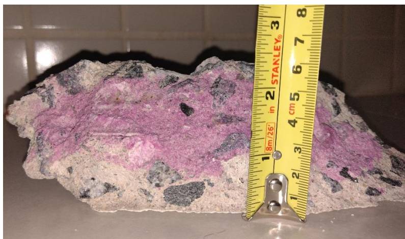
Figura 29 – Ensaio de carbonatação do pilar 3 do bloco 3
