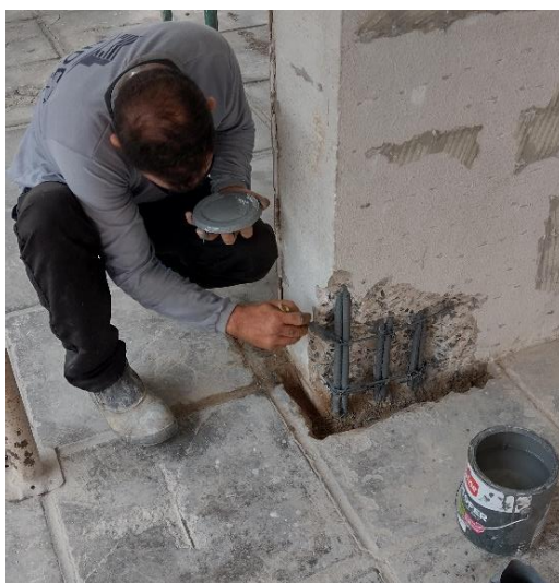
Figura 36 – Pintura com fundo anticorrosivo
