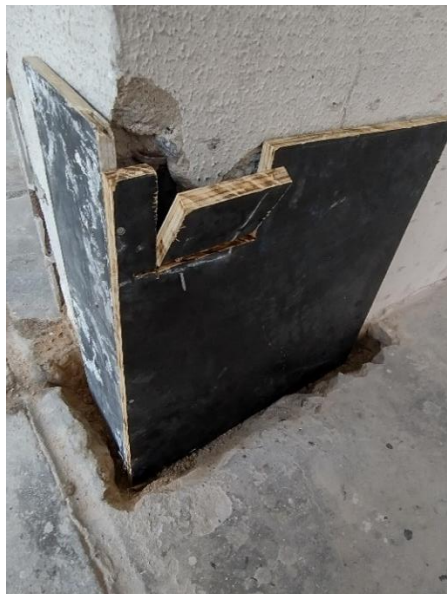
Figura 38 – Vedação da base do pilar
