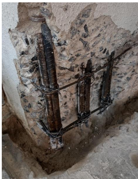
Figura 35 – Substituição dos estribos corrompidos
