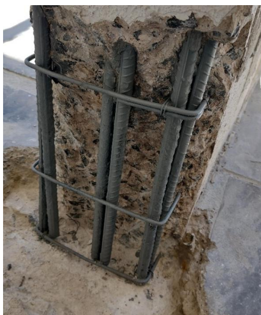
Figura 37 – Armadura e estribos restaurados
