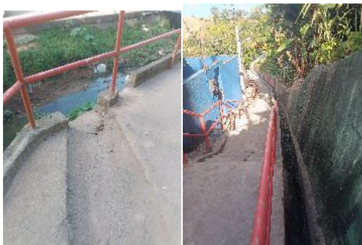
Figura 25 e 26: Sistema de drenagem em escadaria destinado ao Riacho do Cardoso
