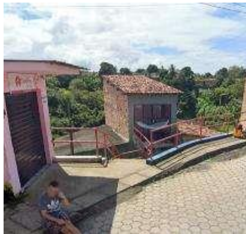
Figura 45 - Acesso pela Rua São João
