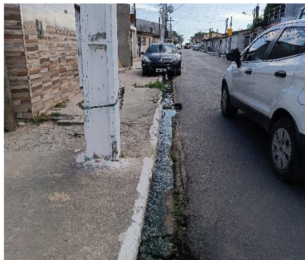
Figura 22: Calha de drenagem presente nos bairros
