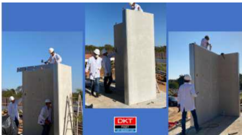
Figura 21: Imagens de uma obra utilizando painéis SIP+MGO
