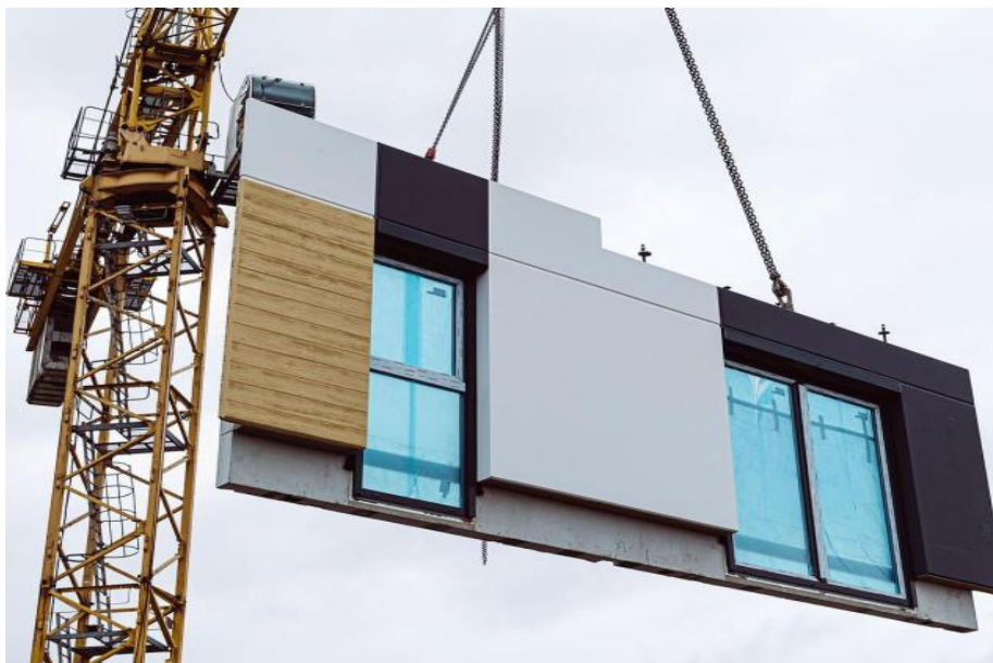
Figura 12: Exemplo de Nível 2 – Montagem de painéis de fachada
