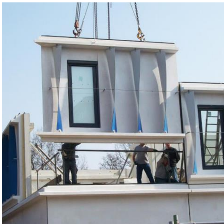
Figura 14: Montagem de um painel de fachada
