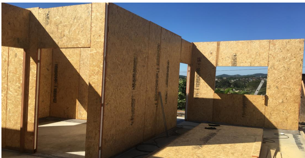
Figura 23: Montagem in loco dos painéis SIP
