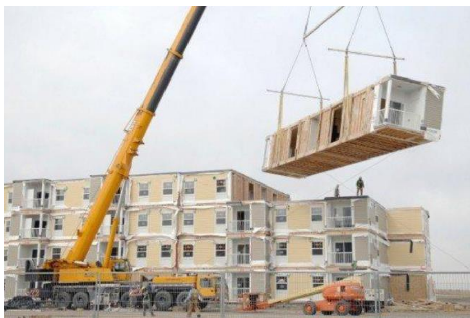
Figura 14: Exemplo de Nível 4 – Módulos de uma edificação sendo conectados
