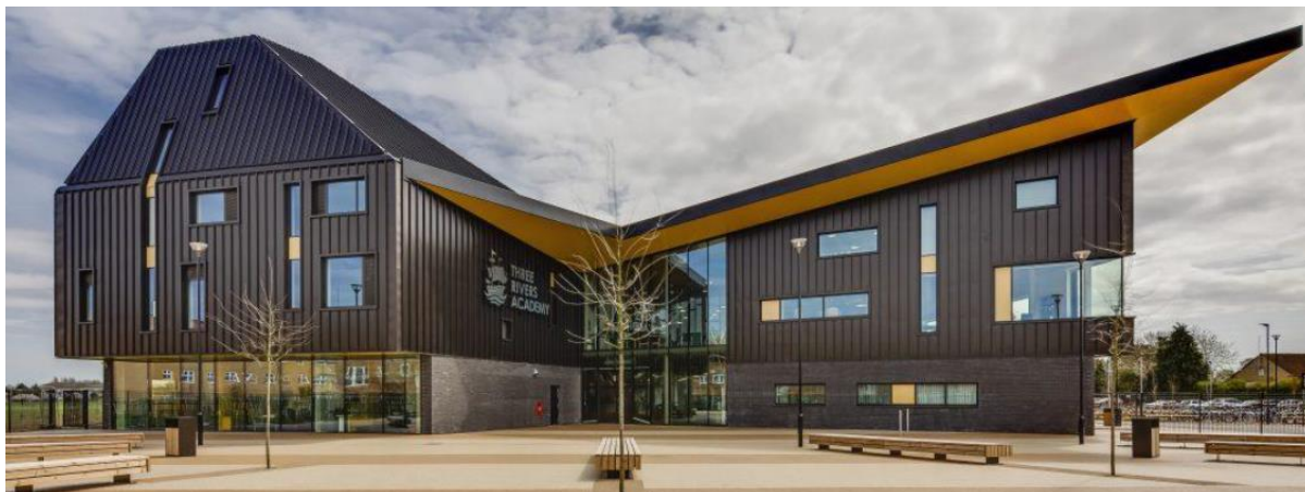
Figura 18: Exemplo de cobertura com ausência de treliças de uma escola do Reino Unido
