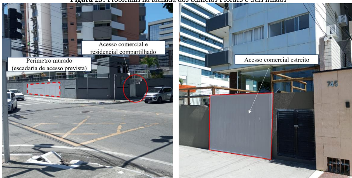
Figura 29: Problemas na fachada dos edifícios Fiordes e Seis irmãos
