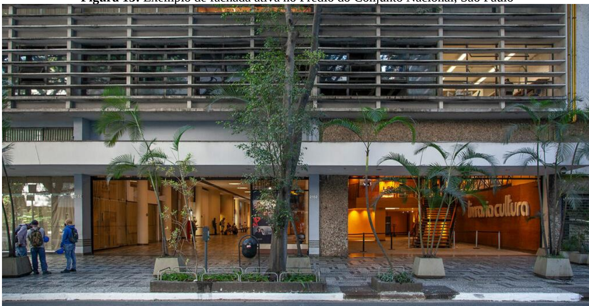
Figura 15: Exemplo de fachada ativa no Prédio do Conjunto Nacional, São Paulo
