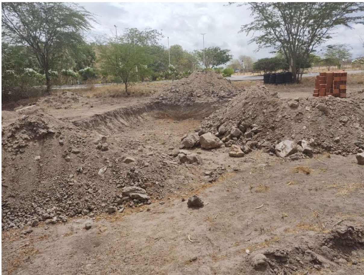
Figura 34 - Área designada para implantação de uma Fossa Verde no Campus Sertão
