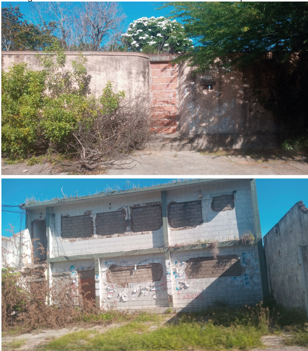
Figura 22 - Prédios e casas da área dos bairros interditados pela Braskem
