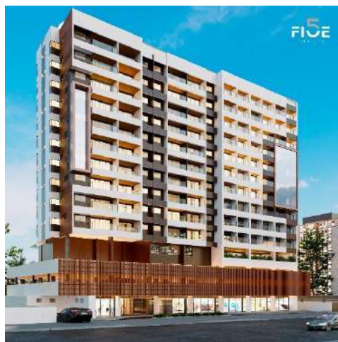
Figuras 42 e 43: Fachada posterior Edifício Five
