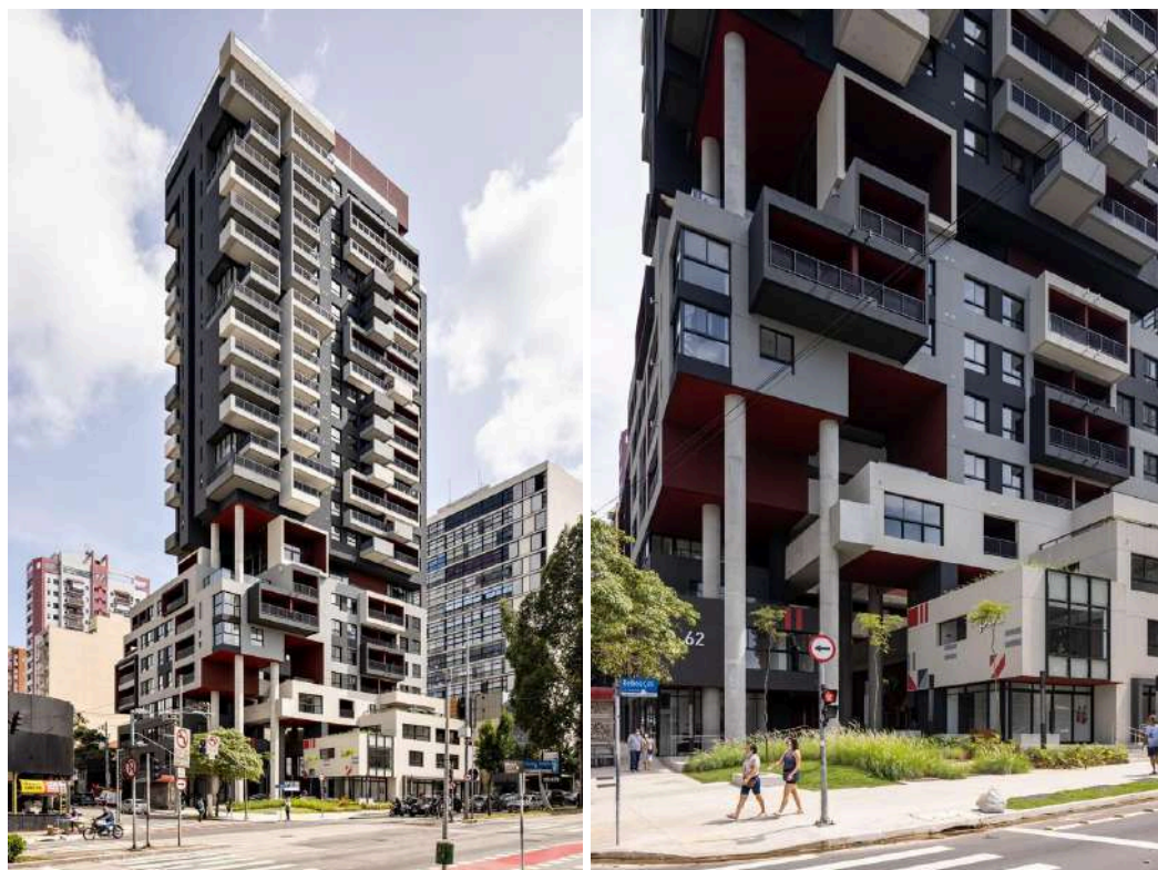
Figuras 22 e 23: Fachada do Edifício POD
