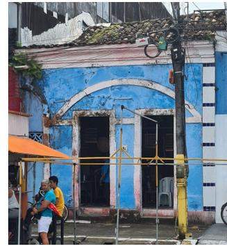
Edificação em processo de descaracterização pelo desmembramento de lote e perda da metade da fachada, outrora, simétrica. Telhado em telha colonial cerâmica com acabamento em cimalha. Desenhos geométricos emoldurando as aberturas.
