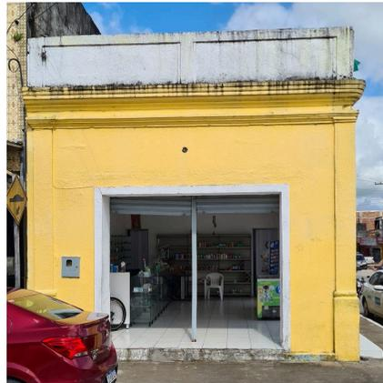
Edificação de esquina com fachada de poucos adornos, com acabamento da cobertura em platibanda, porém presença de cimalha indica que a platibanda foi acrescida posteriormente.
