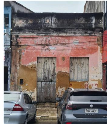
Edificação geminada com fachada livre de adornos, esquadria tipo saia e blusa, com acabamento da cobertura em platibanda, porém presença de cimalha indica que a platibanda foi acrescida posteriormente.
