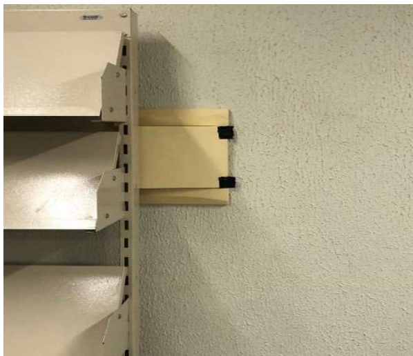
Figura 11 - Rede de cabeamento exposto
