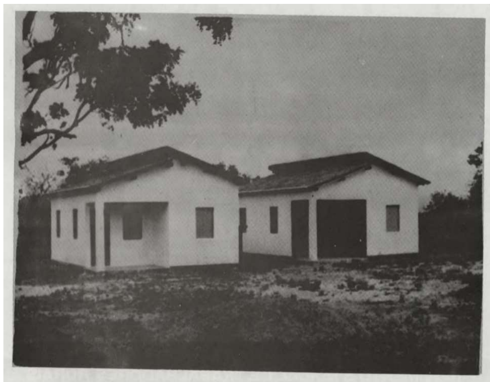
Figura 21 – Modelo de casas construída pela Chesf para os reassentados
