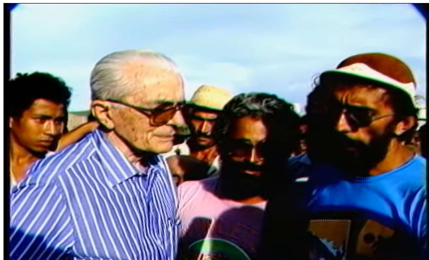
Figura 18 - O Ministro de Minas e Energia no canteiro de obras da CHESF.
