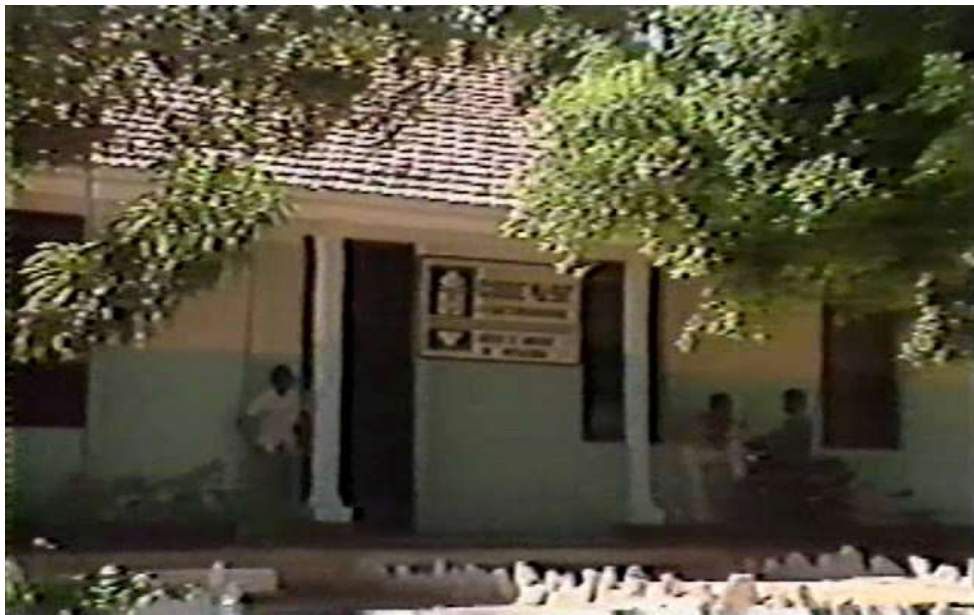
Figura 7 - Escritório da SUVALE em Barreiras Velha
