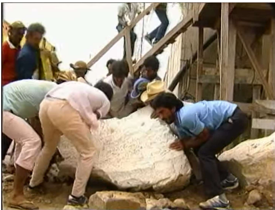
Figura 16 - Trabalhadores movendo pedras para fazer barreiras
