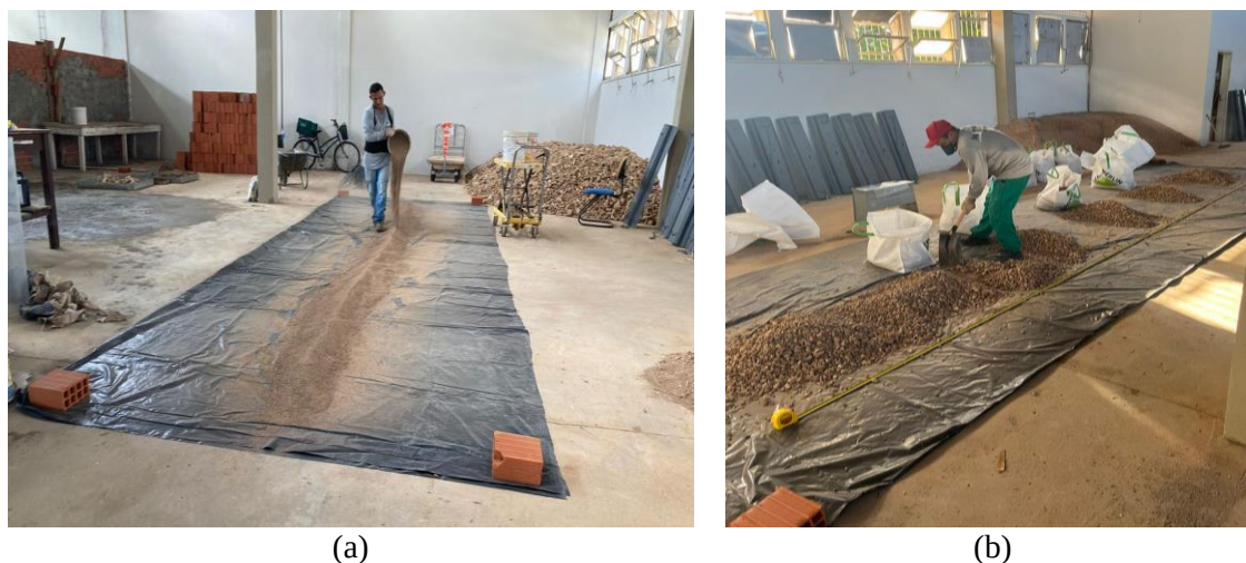
Figura A.1 - Execução de pilhas na etapa de execução das amostras de AMRP (a) e AGRP (b)
