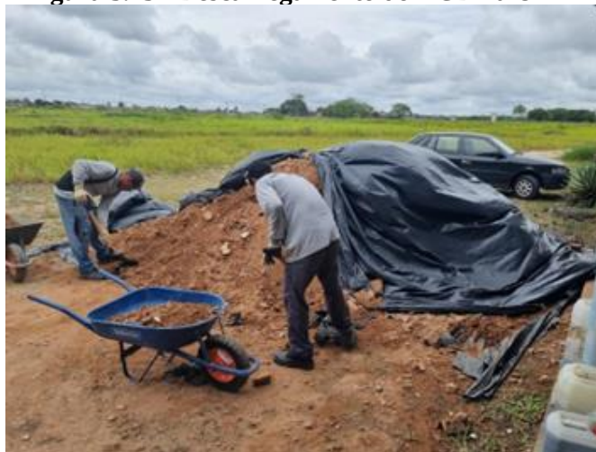
Figura 5.15 - Descarregamento do RCD na UFAL
