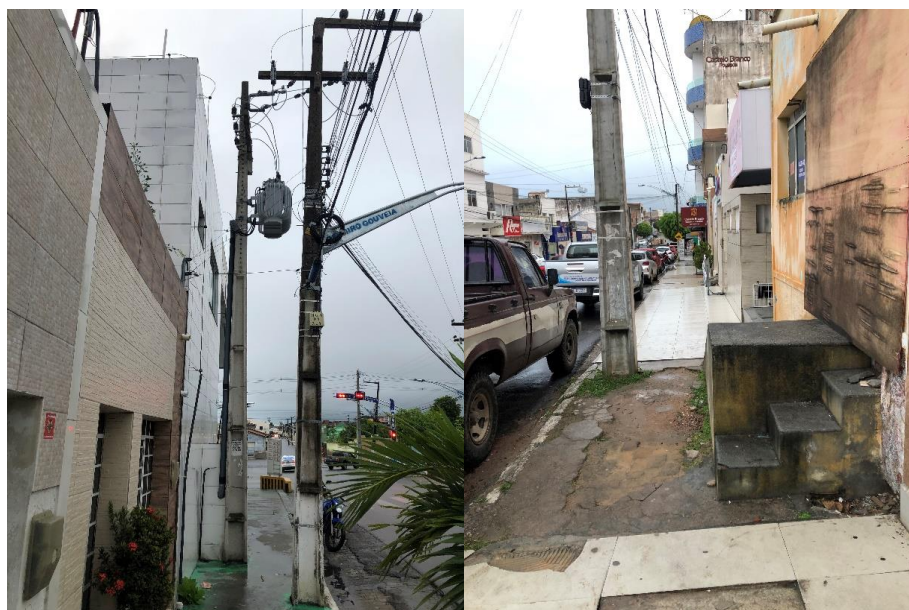
Figura 18: Degraus, postes e desníveis obstruindo a faixa livre e impedindo a boa circulação nos trechos 01 e 18.
