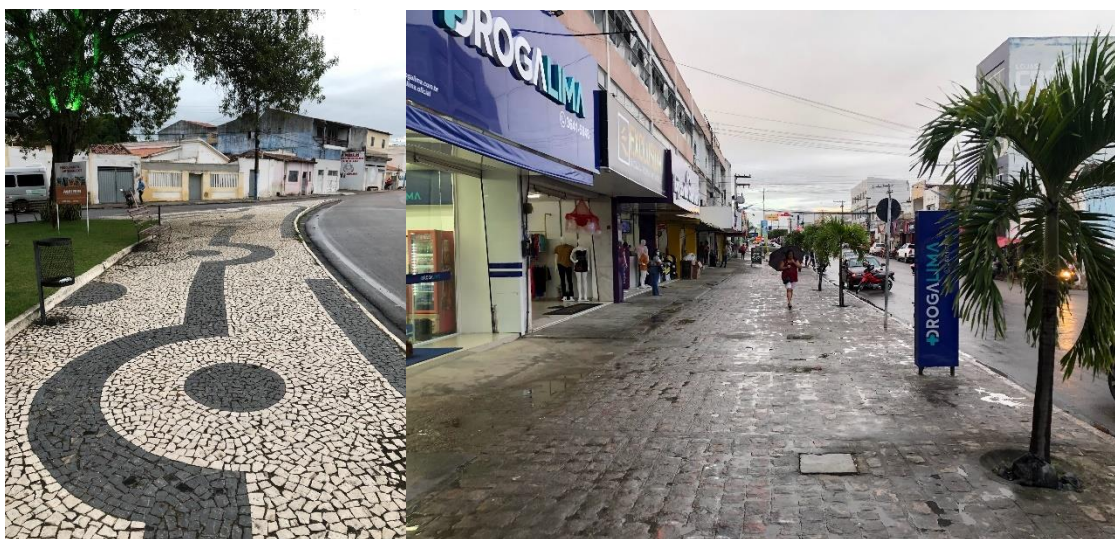
Figura 17: Faixa livre atendendo à largura mínima e inclinações estabelecidas em norma nos trechos 11 e 17.
