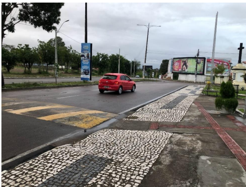
Figura 25: Rampa com identificação tátil e de alerta no trecho 11.
