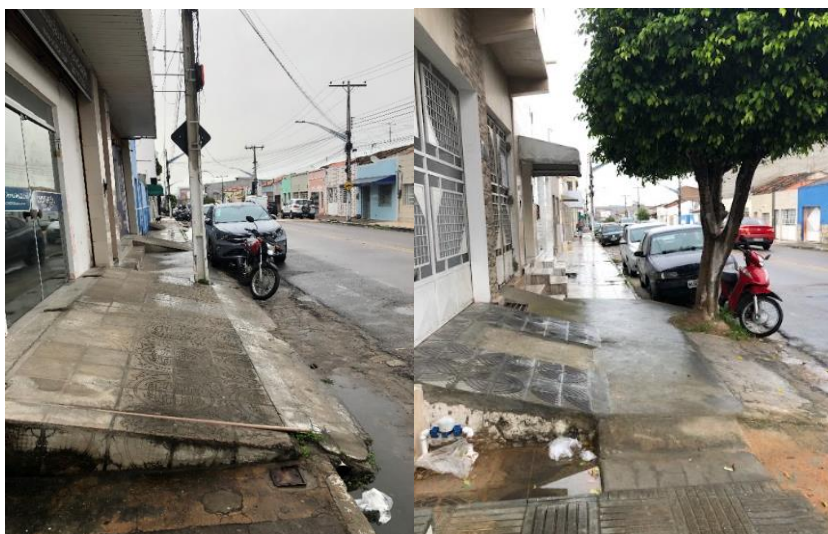
Figura 26: Acesso a garagem obstruindo a faixa livre no trecho 19.
