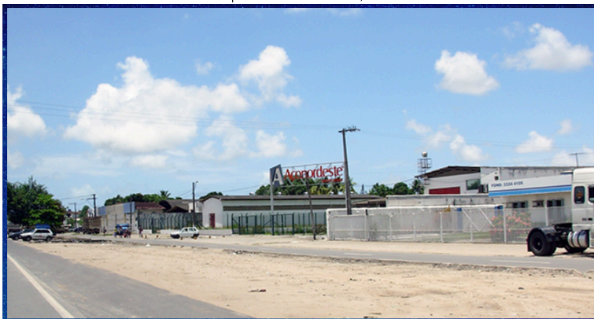
FIGURA 12 | Bairro do Clima Bom, Maceió-AL
