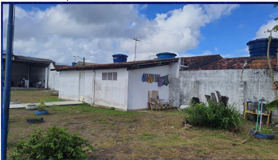
FIGURA 23 | Vista Lateral Direita da Nova Sala de Recursos Multifuncionais
