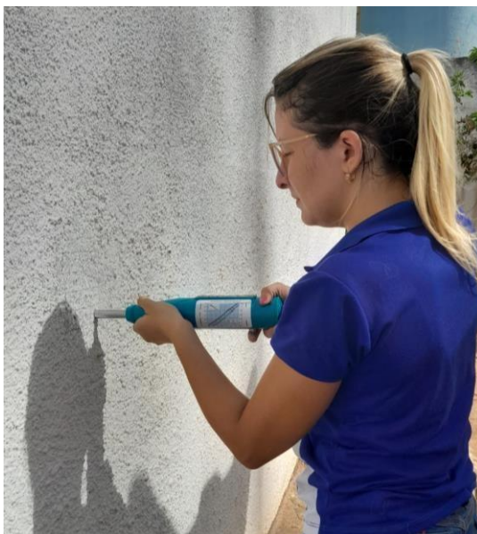
Figura 25: Realização do ensaio na parede 1.
