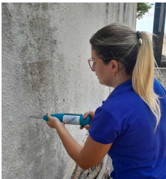
Figura 26: Realização do ensaio na parede 2.
