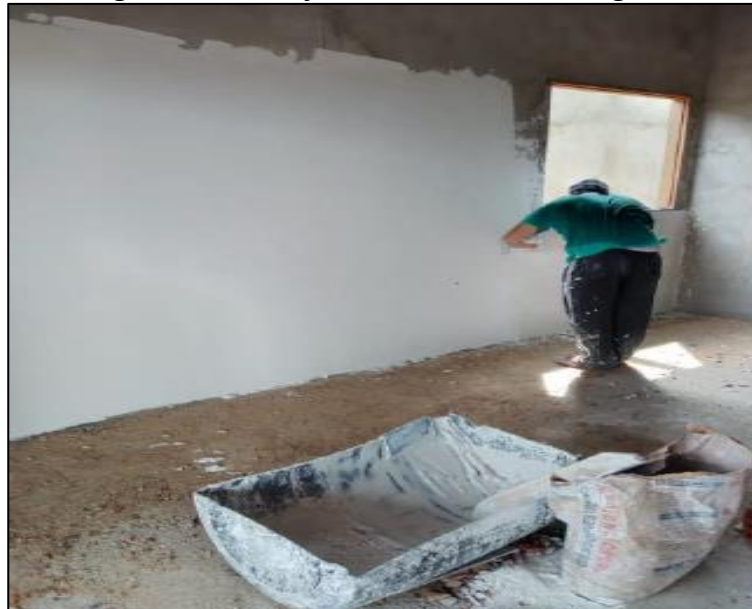
Figura 3 - Execução de revestimento em gesso
