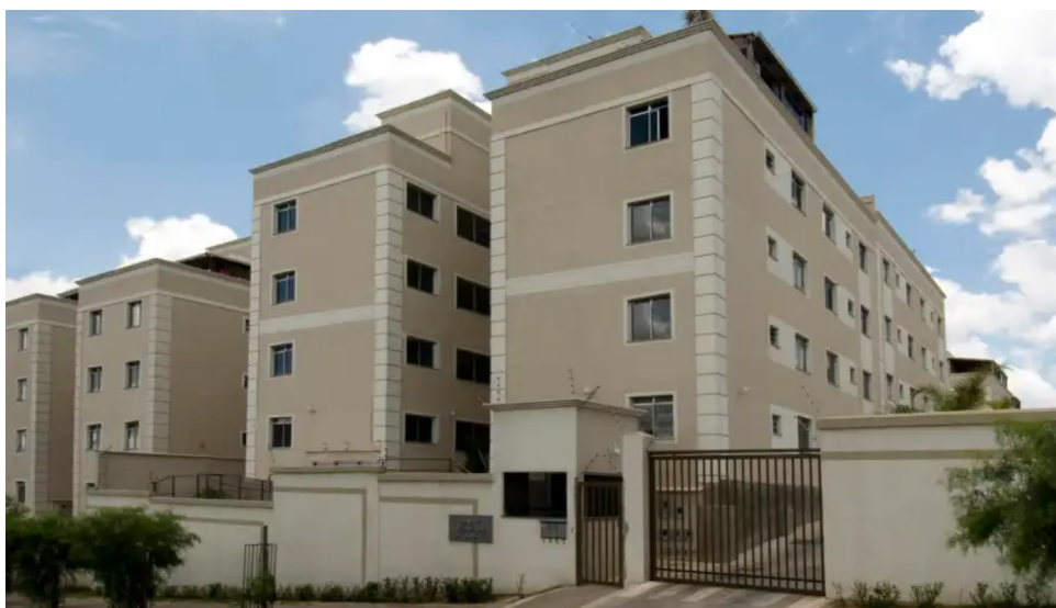
Figura 21 – Edifício de concreto moldado no local
