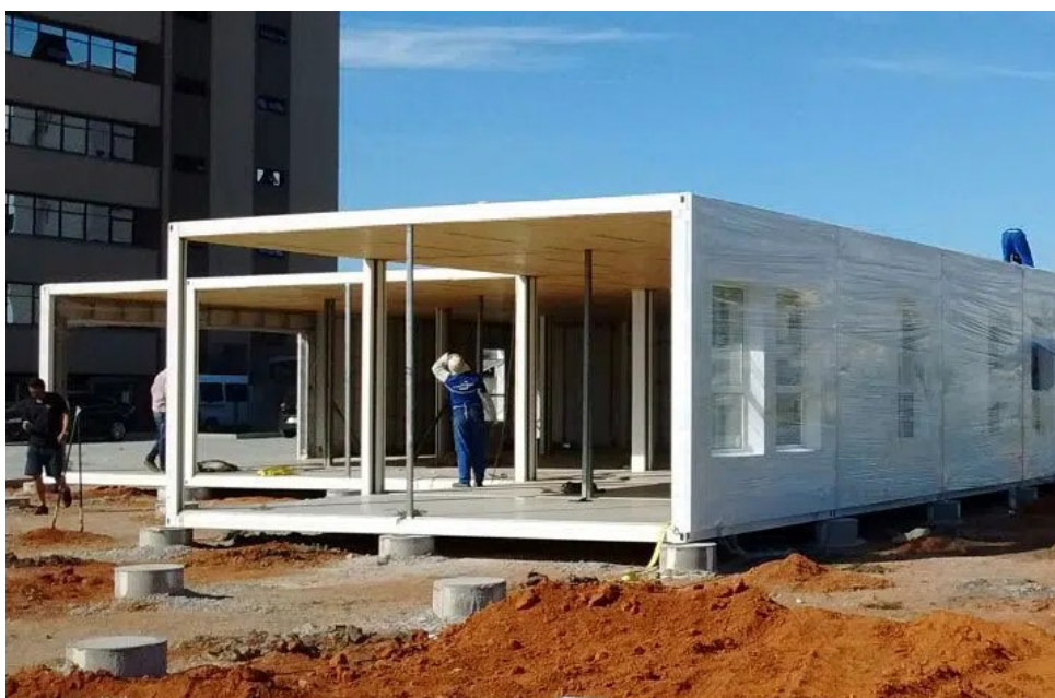
Figura 7 – Fase B - Instalação Final e Ajustes Finos.
