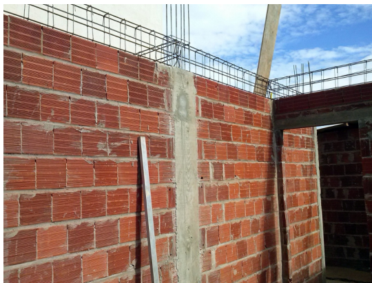
Figura 18 – Sistema de Alvenaria Convencional
