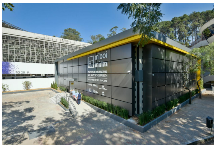
Figura 9 – Centro de Tratamento do Hospital M'Boi Mirim
