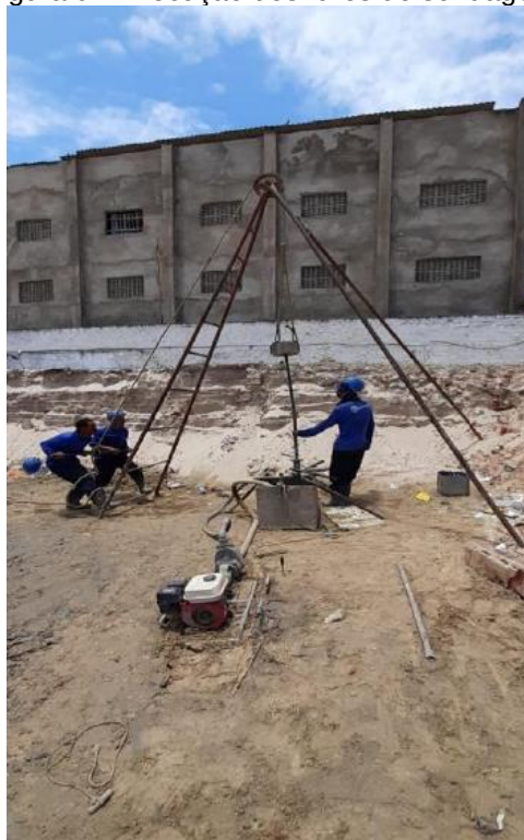
Figura 9 - Execução dos furos de sondagem
