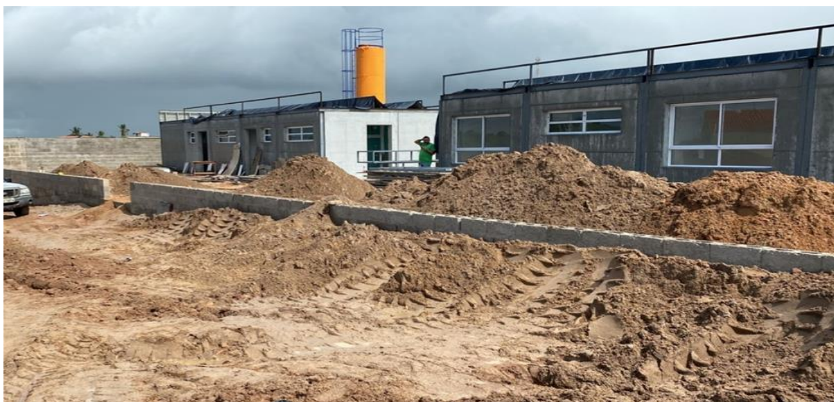
Figura 12 - Aterro sendo executado.
