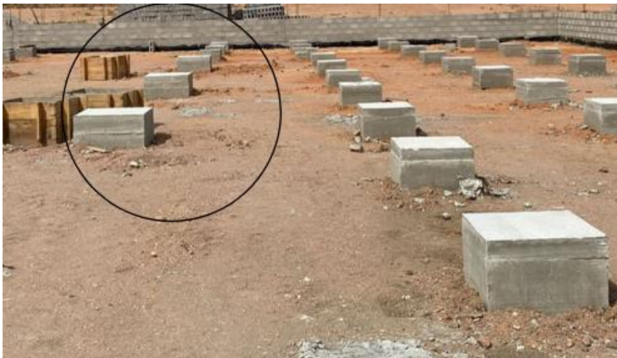
Figura 08 - Blocos da fundação concretados.
