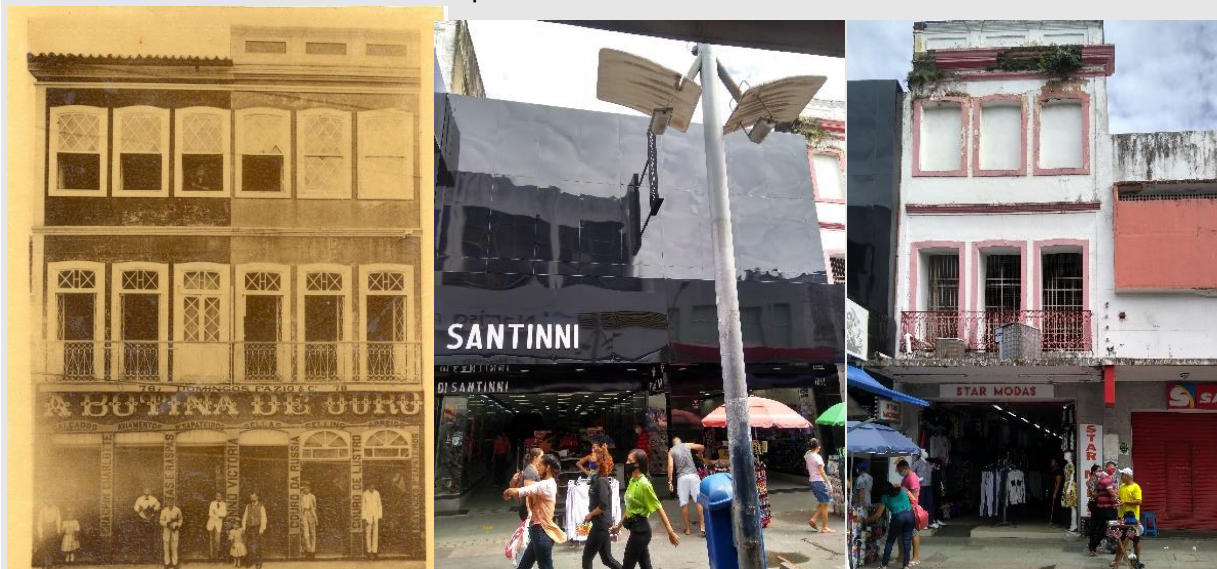
Imagem 75: Mesmo imóvel em épocas distintas. Nota-se as aberturas em parte do imóvel totalmente coberta e o pavimento térreo totalmente descaracterizado.
