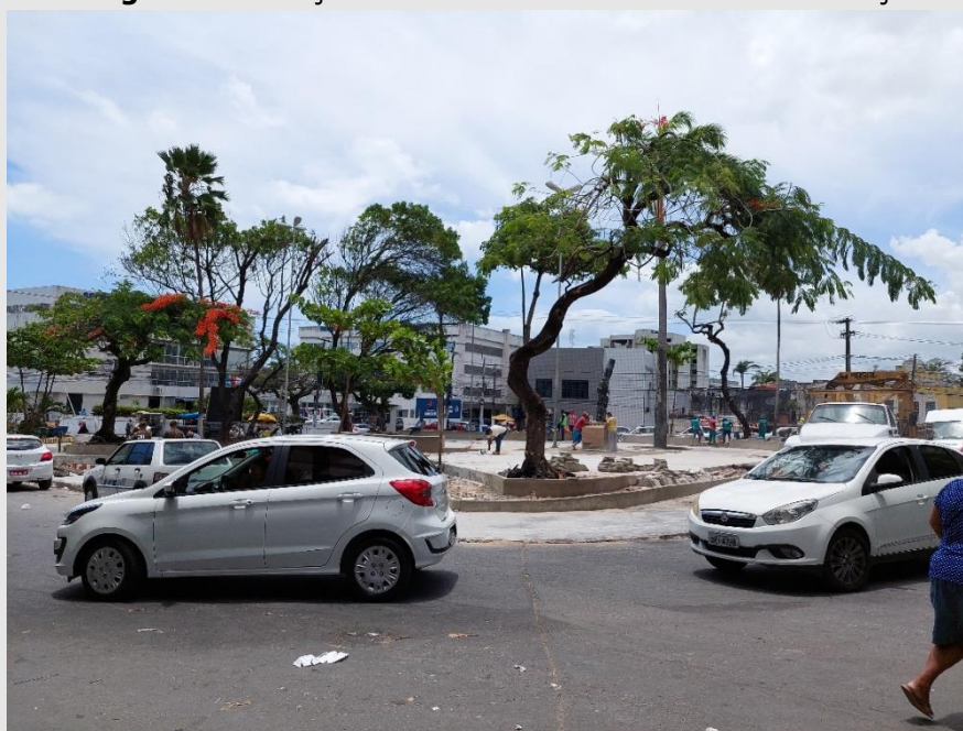
Imagem 105: Praça dos Palmares durante obras de revitalização.
