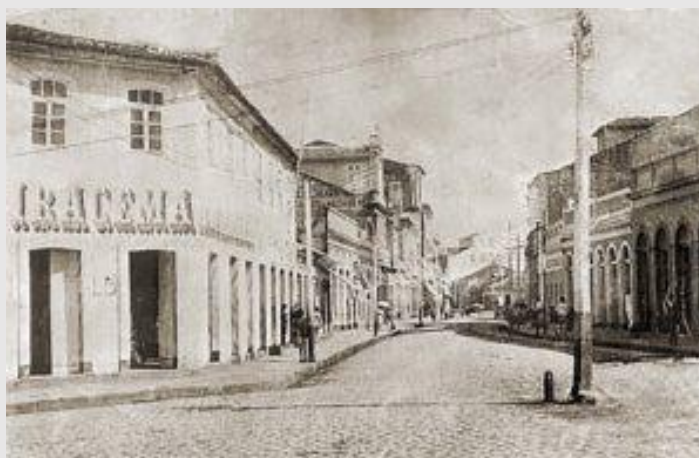
Imagem 10: Poste elétrico na Rua do Comércio.
