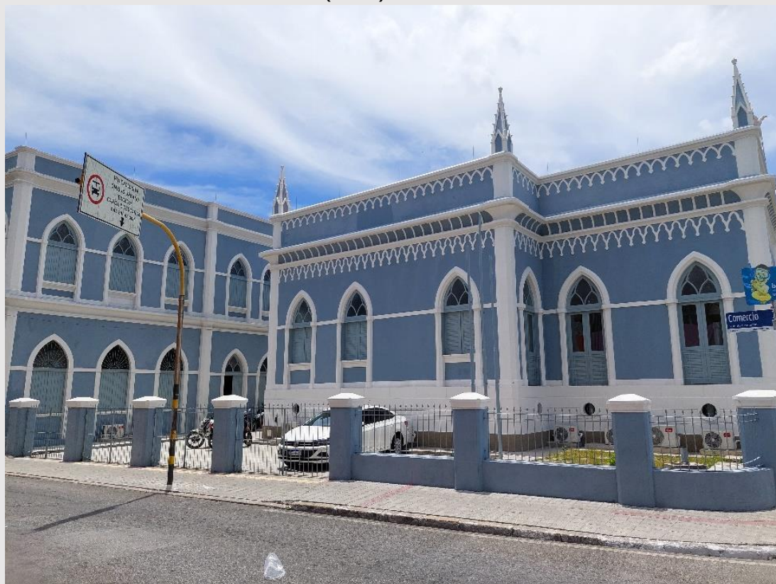
Imagem 144: Laterais da antiga Intendência Municipal, agora sede da Fundação Municipal de Ação Cultural (FMAC).
