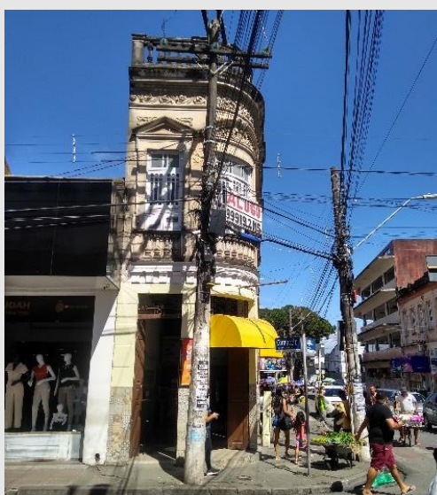
Imagem 79: Exemplo de imóvel com a testada estreita e geminado ao lote vizinho na esquina da Rua do Comércio com a Rua das Árvores.
