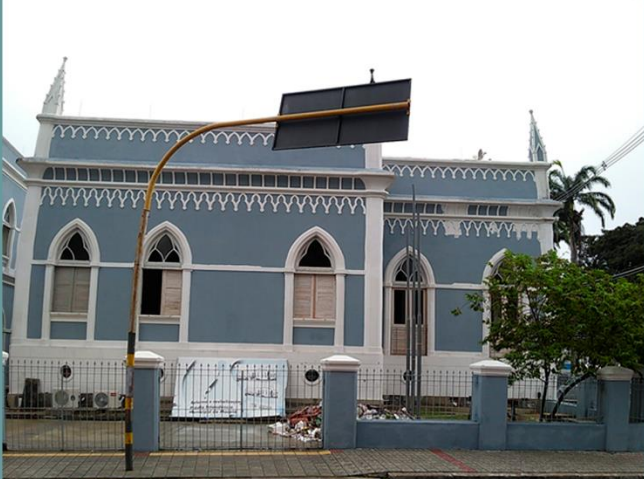
Imagem 39: Laterais da antiga Intendência Municipal, imóvel em fase de obras (não tombado).
