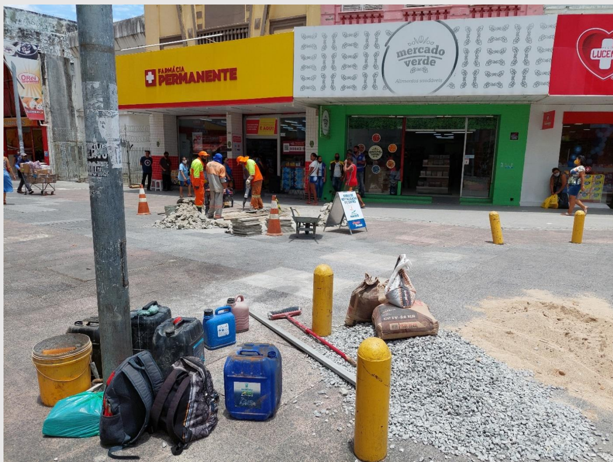
Imagem 131: Obras na Rua do Comércio em dezembro de 2021.
