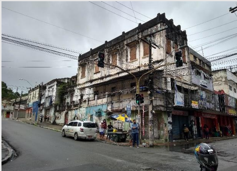
Imagem 36: Imóveis vazios em estado de degradação localizados na Rua das Árvores.
