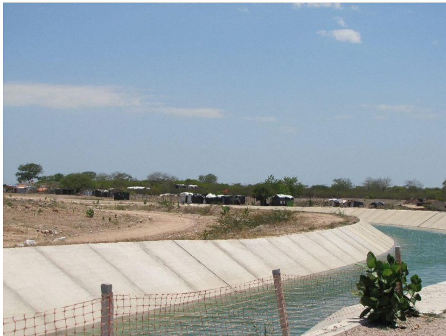
Figura 16 - Obra do canal do Sertão ainda com solo exposto.
