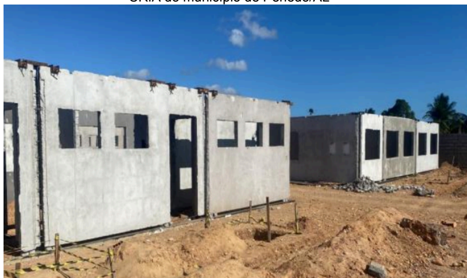
Figura 27: Montagem dos painéis de EPS com revestimento de concreto armado, da Creche CRIA do município de Penedo/AL
