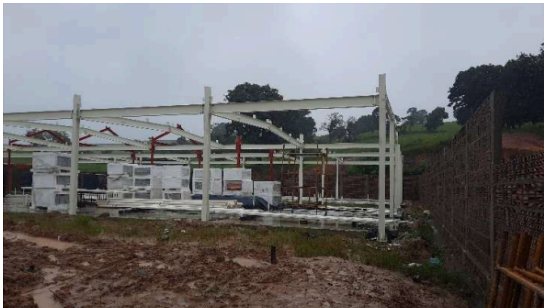
Figura 14: Montagem da estrutura metálica da Creche CRIA do município de Pindoba/AL
