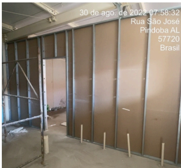
Figura 20: Execução do sistema de drywall nas divisórias internas da Creche CRIA do município de Pindoba/AL
