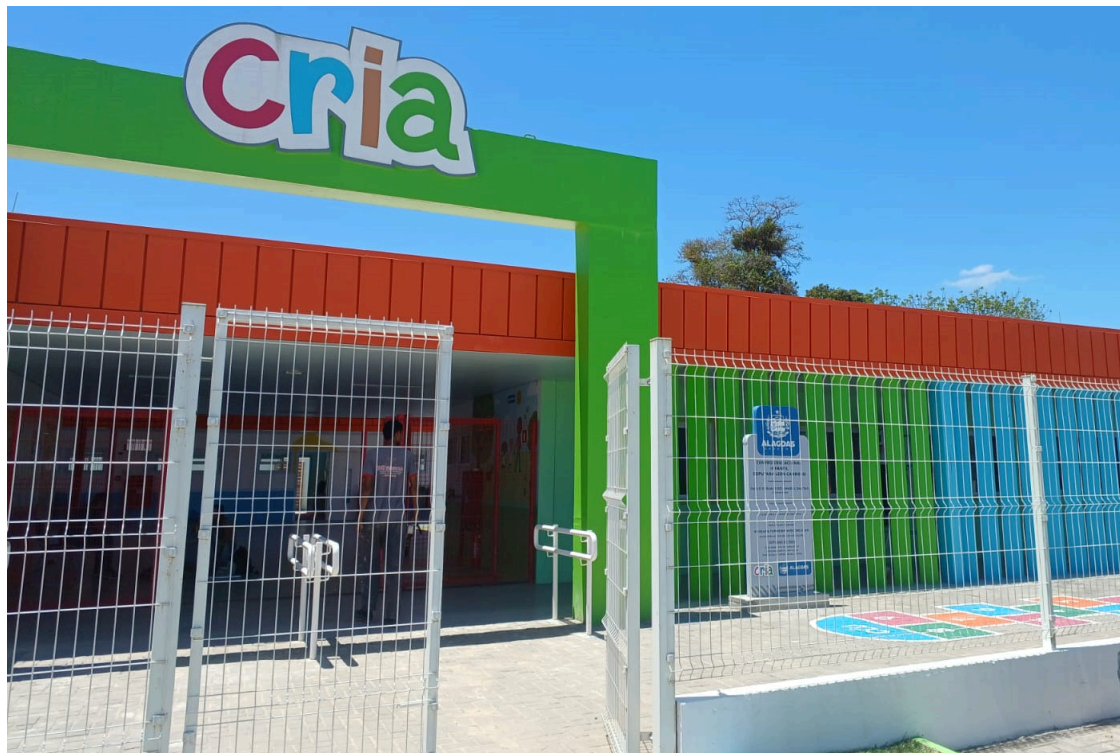
Figura 13: Fachada da Creche CRIA do município de Pindoba/AL
