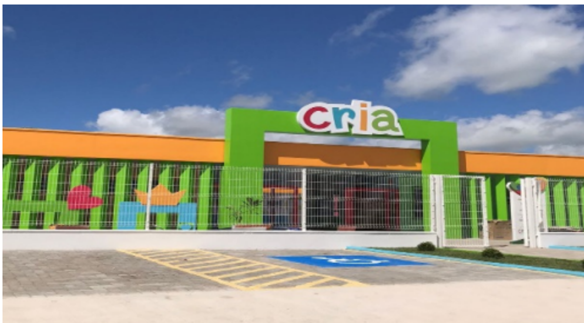
Figura 30: Fachada da Creche CRIA do município de Jacaré dos Homens/AL
