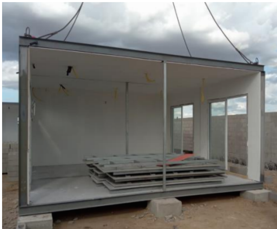
Figura 31: Posicionamento do módulo através de guindaste na Creche CRIA do município de Jacaré dos Homens/AL
