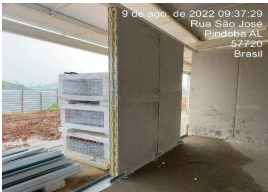
Figura 16: Montagem dos painéis SmartWall da Creche CRIA do município de Pindoba/AL
