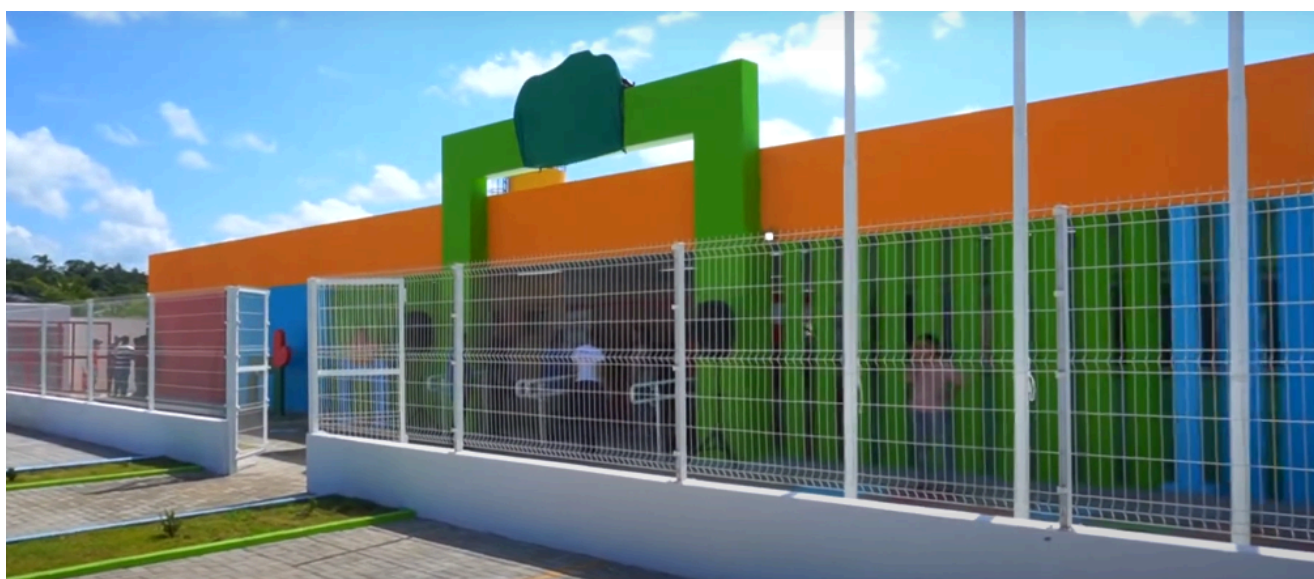
Figura 24: Fachada da Creche CRIA do município de Penedo/AL
