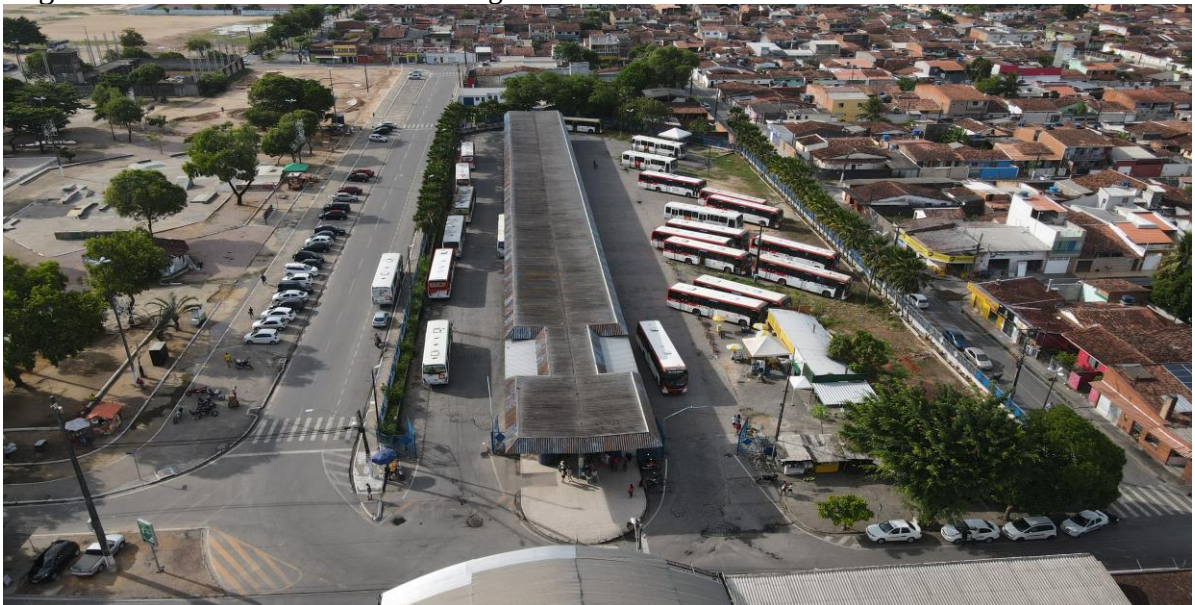
Figura 22 - Vista aérea do terminal Integrado do Benedito Bentes
