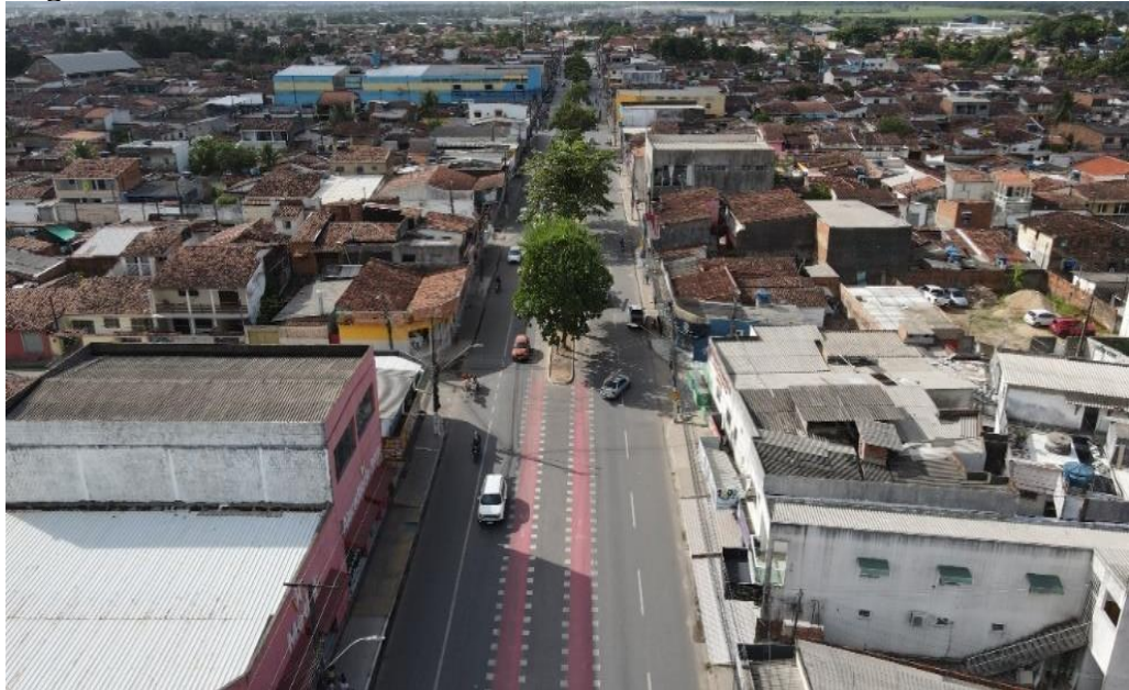
Figura 16 - Vista aérea da avenida Benedito Bentes
