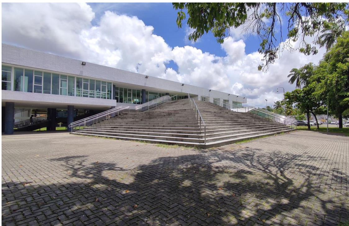
Figura 29: Escadaria/ Palco para acesso principal ao Compaz
