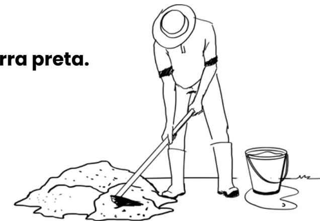
Não há uma proporção certa de barro e água a ser misturado, a quantidade é no "olhômetro" e no "pisometro", até você sentir que chegou na consistência ideal. Se ficar muito molhado, desmanchará após retirado da forma. Já se permanecer muito seco, ficará feio quando desenformado. Não esqueça de acrescentar a terra preta na mistura, ela contribui com a qualidade e resistência do adobe.
