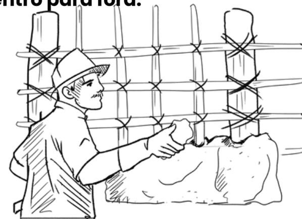
Com todos os processos anteriores concluídos, chegou o momento de barreiar as paredes. Com a proporção de uma mão, pegue o barro e faça o embrechamento entre as madeiras. Este processo é necessário fazer dos dois lados da parede.
