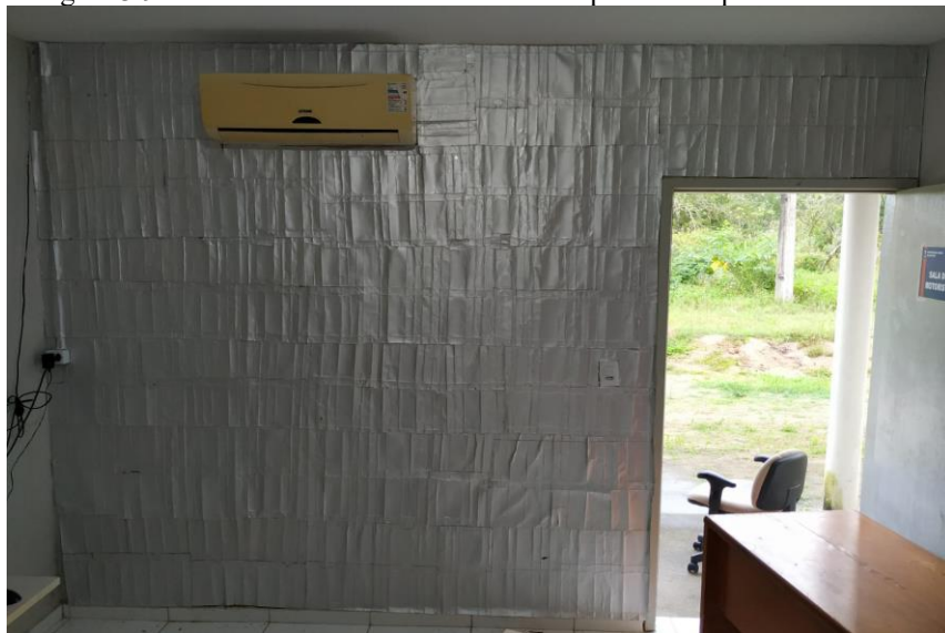
Figura 3.9 - Placas de caixa de leite aderidas a parede do quarto em estudo.
