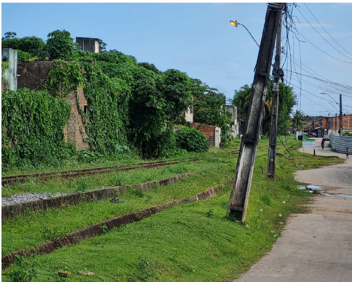
Figura 10 - Linha férrea interditada no bairro do Bom Parto em Maceió/AL
