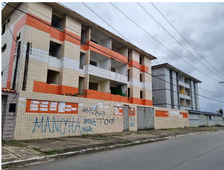
Figura 5 - Edifício lacrado após a saída dos antigos moradores no bairro do Pinheiro em Maceió/AL
