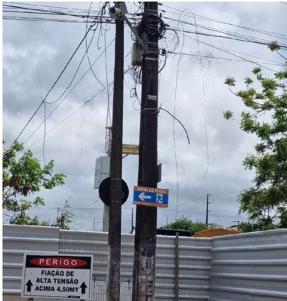
Figura 1 - Placa de aviso sobre a rota de fuga de moradores no bairro do Pinheiro em Maceió/AL
