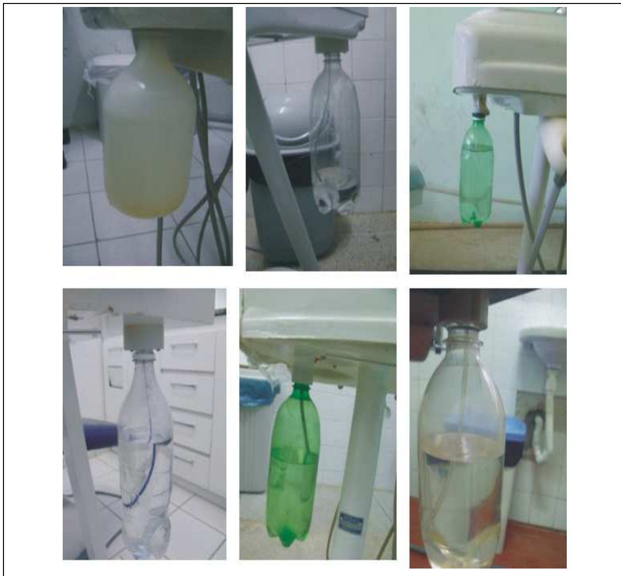
Figura 3- Reservatórios encontrados em cada equipo no dia da coleta.
