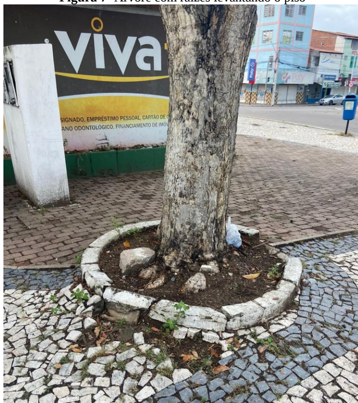
Figura 7- Árvore com raízes levantando o piso
