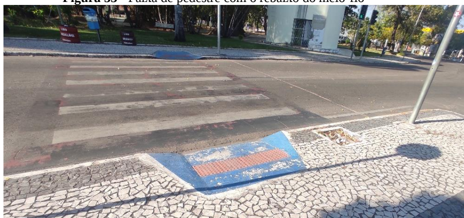
Figura 33 - Faixa de pedestre com o rebaixo do meio-fio
