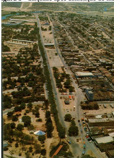
Figura 3 - Calçadão após demolição do muro
