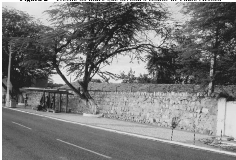
Figura 2 – Trecho do muro que dividia a cidade de Paulo Afonso
