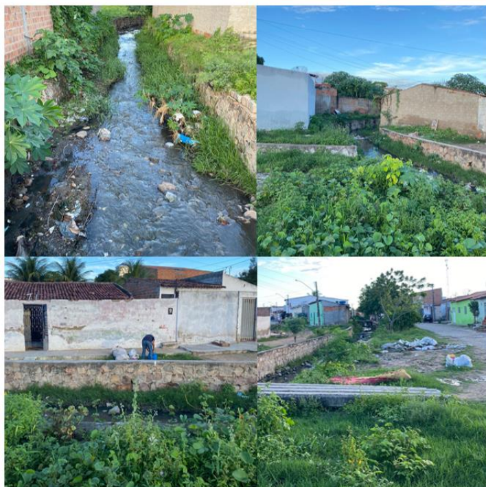
Figura 15 – Lançamento de esgoto doméstico ao longo do canal escolhido.
