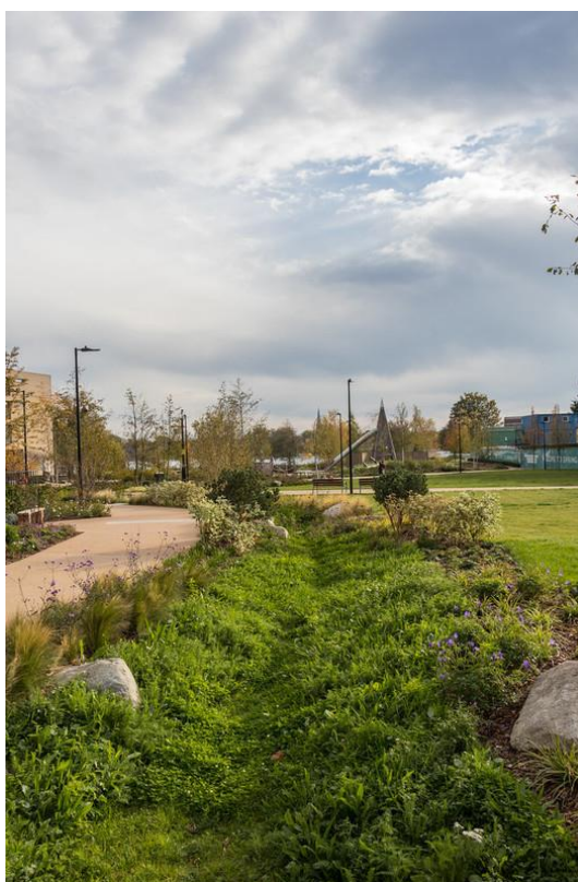
Figura 10 – Vala de infiltração instalada no bairro de Woodberry Down, em Londres.
