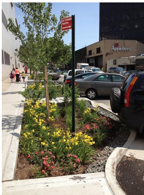
Figura 8 – Jardim de chuva instalado no bairro de Elmhurst em Nova York.
