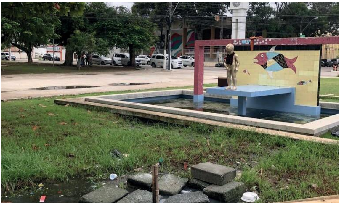
Figura 18 - Atual estado da estátua que serve de varal, e o local onde estava sua bomba
