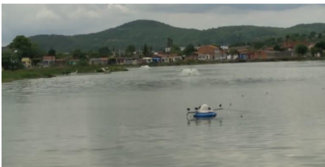
FIGURA 10: Bombas de oxigênio instaladas na Lagoa Caiçara.
