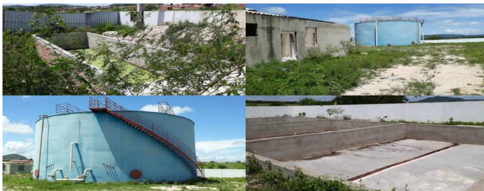
FIGURA 13: Estação de tratamento e saneamento básico inativa.
