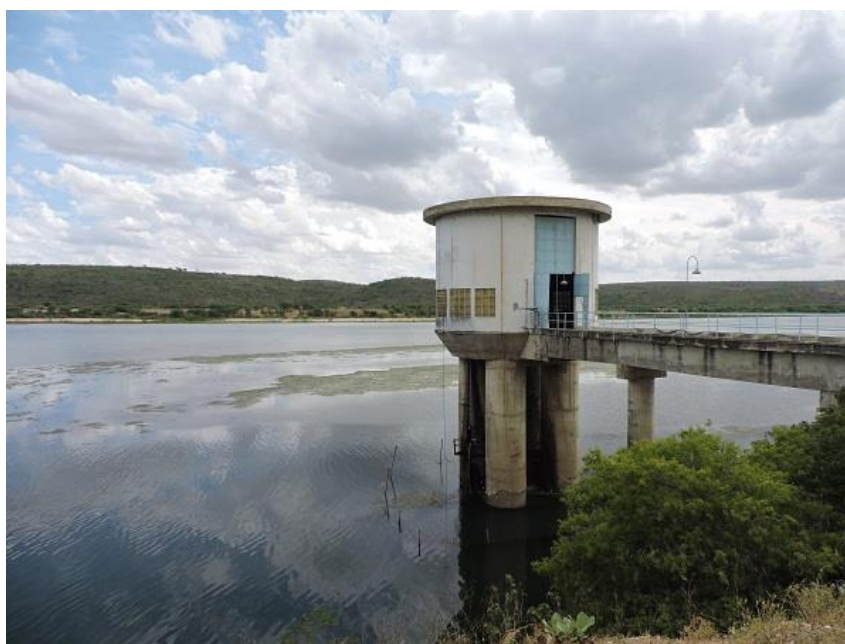
FIGURA 7 – Estação Elevatória Nº 1 em Pão de Açúcar – AL.
