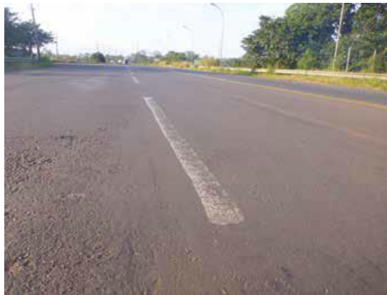
Figura 7: Desgaste
