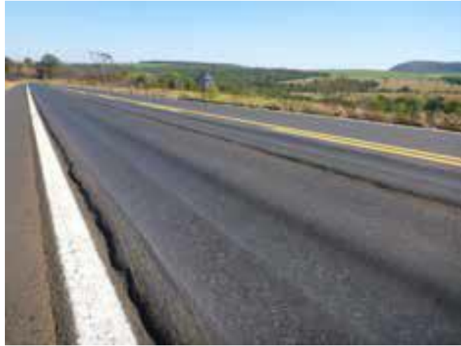
Figura 3: Afundamento plástico
