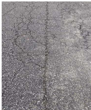
Figura 13: Trinca longitudinal
