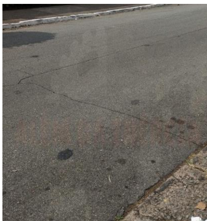
Figura 12: Trinca transversal
