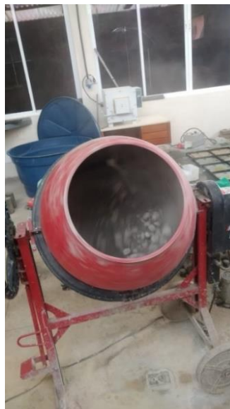
Figura 20 – Preparo do concreto em betoneira
