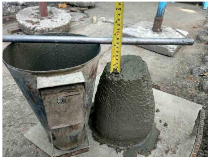
Figura 21 – Ensaio de Slump Test
