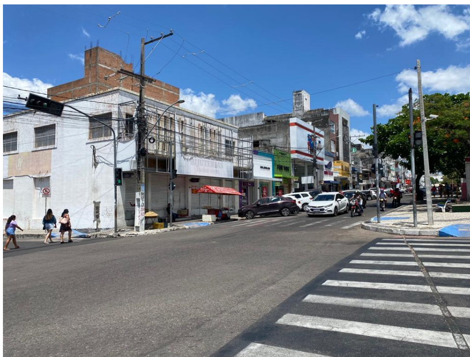
Figura 14 – Laterais dos prédios na av. Getúlio Vargas
