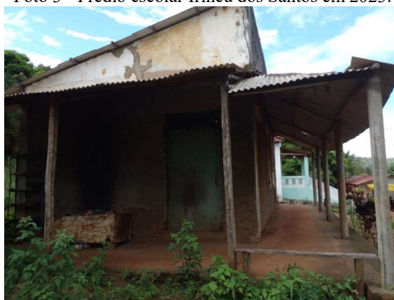
Foto 3 - Prédio escolar Irineu dos Santos em 2023.
