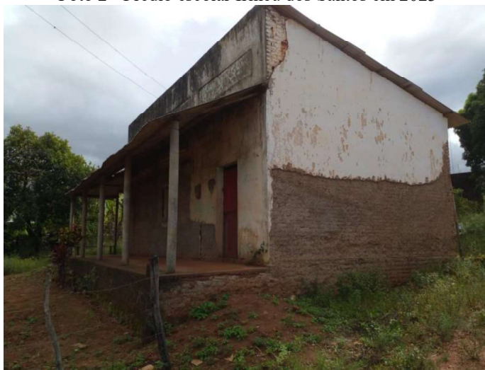
Foto 2 - Prédio escolar Irineu dos Santos em 2023
