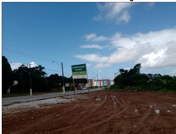
Figura 13 - Construção do mirante Santa Amélia - APA de Catolé e Fernão Velho – Alagoas – Brasil
