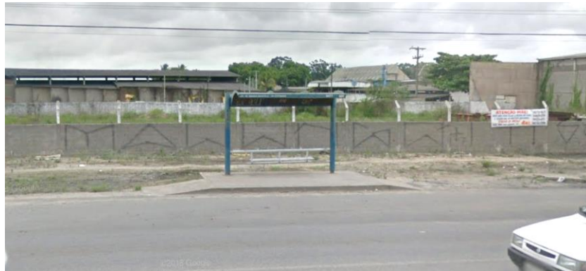
Figura 26 – Parada de ônibus com abrigo na Av. Menino Marcelo com rampa de acessibilidade sobre área sem pavimentação.
