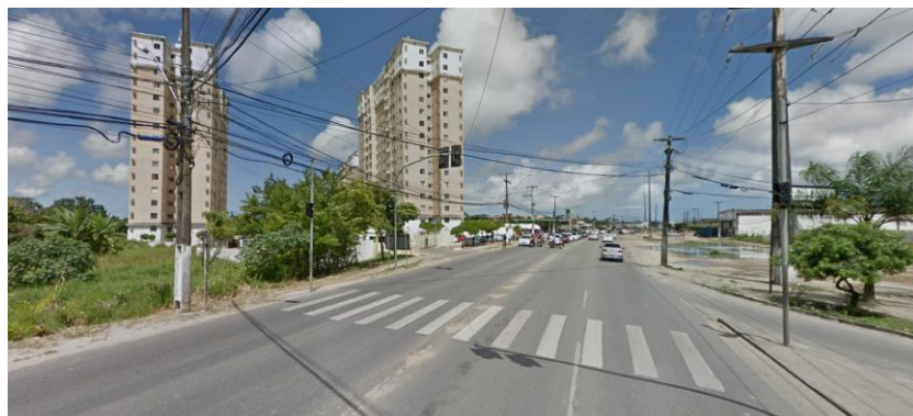
Figura 27 – Faixa de pedestre na Av. Menino Marcelo, em frente ao Hiper Bom Preço, que encaminha o pedestre a condições inadequadas para caminhar.
