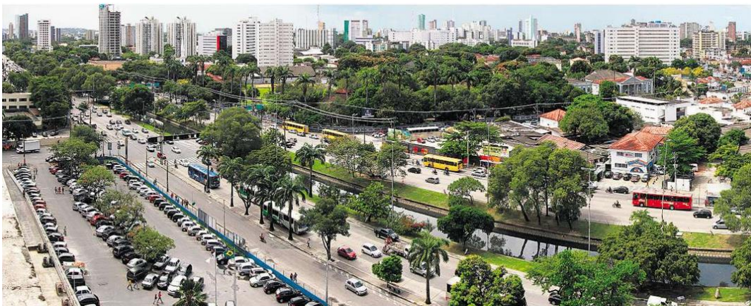
Figura 13 - Trecho da Avenida Agamenon, Recife – PE.
