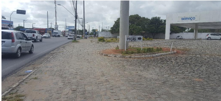
Figura 32 - Pavimentação para facilitar o acesso de carros à concessionária de veículos.
