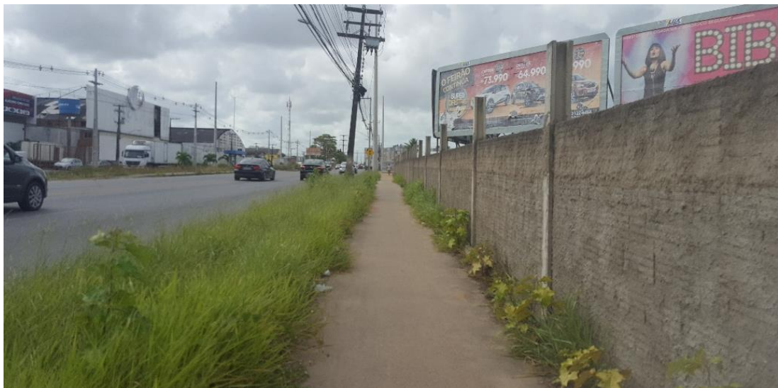
Figura 35 - Fachada cega provocada por gleba murada não-edificada.
