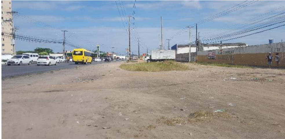
Figura 23 - Inexistência de calçada e fachadas recuadas.
