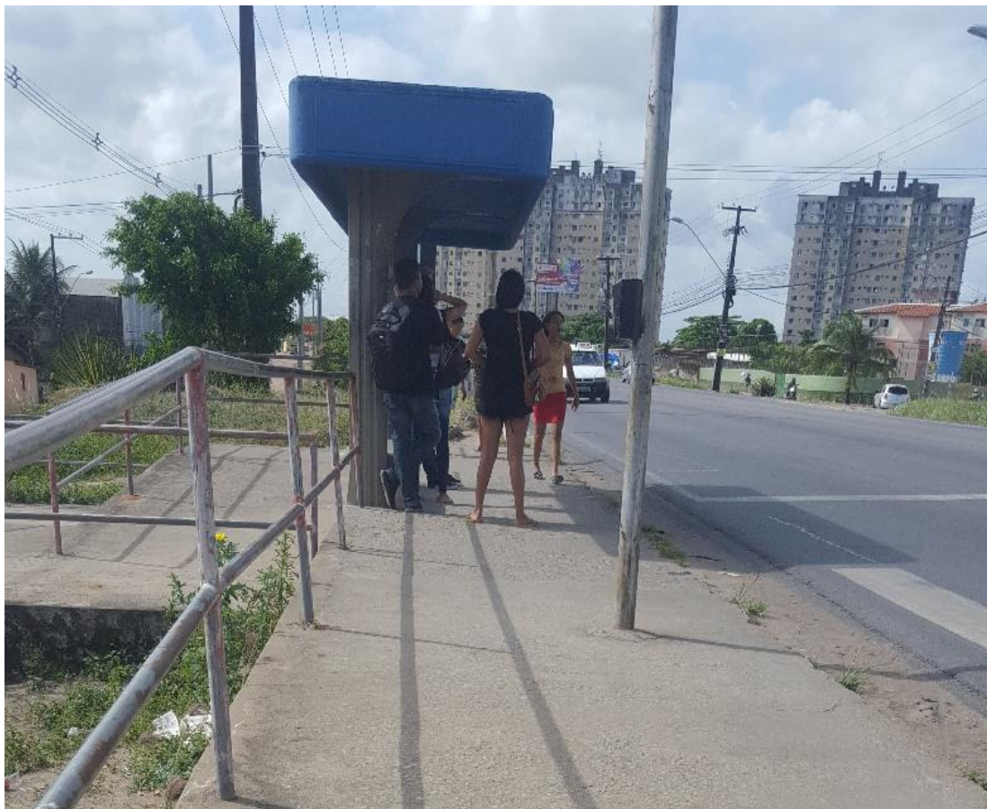
Figura 36 - Parada de ônibus sem assento no lado Oeste da Av. Menino Marcelo.
