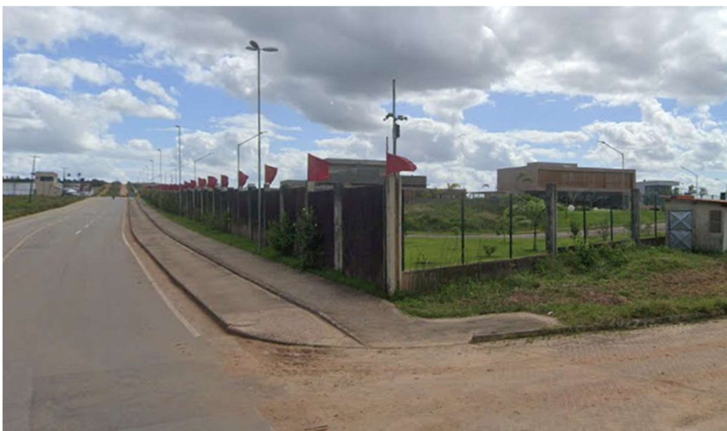
Figura 13 - Calçada do condomínio Reserva Perucaba
