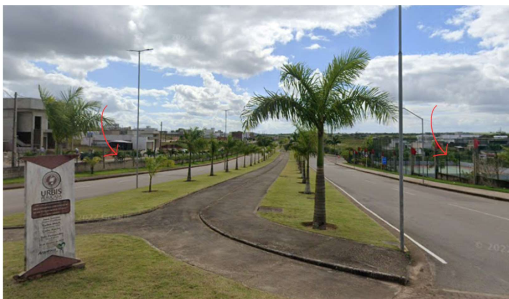
Figura 9 - Vista dos gradis para o interior
