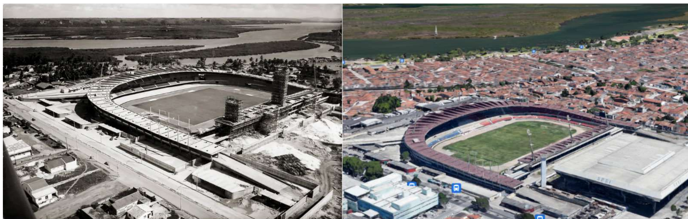
Figura 04 - Imagem da construção do Estádio Rei Pelé em 1969 antes da construção do Dique-Estrada e ao lado em 2021. Fonte: História de alagoas, 2015 e Google Earth, 2021
