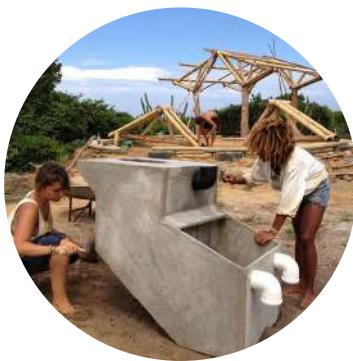
Figura 84 - Bason sendo construído. Fonte: Archdaily, 2022
