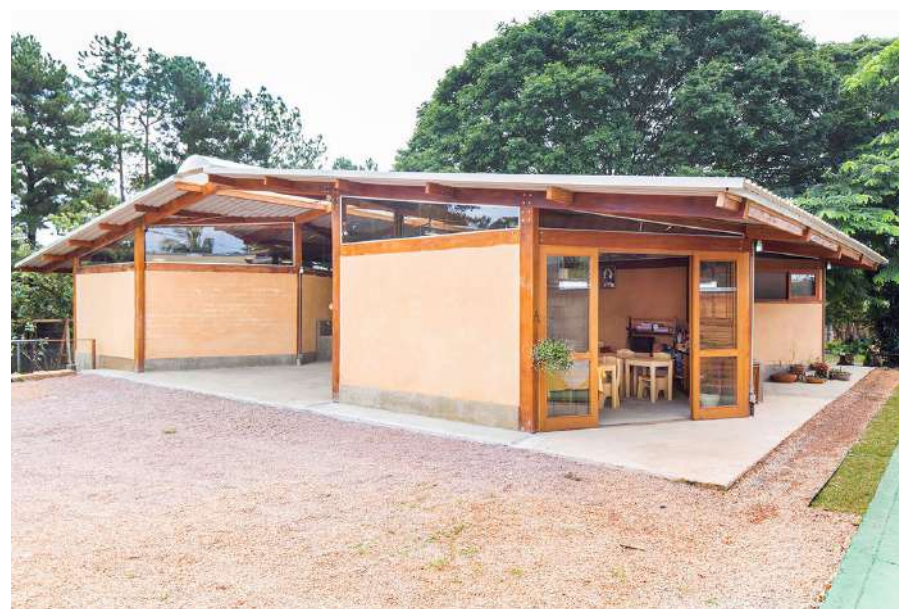
Figura 37 - Vista Posterior Escola Ecoara. Fonte: Archdaily, 2022.
