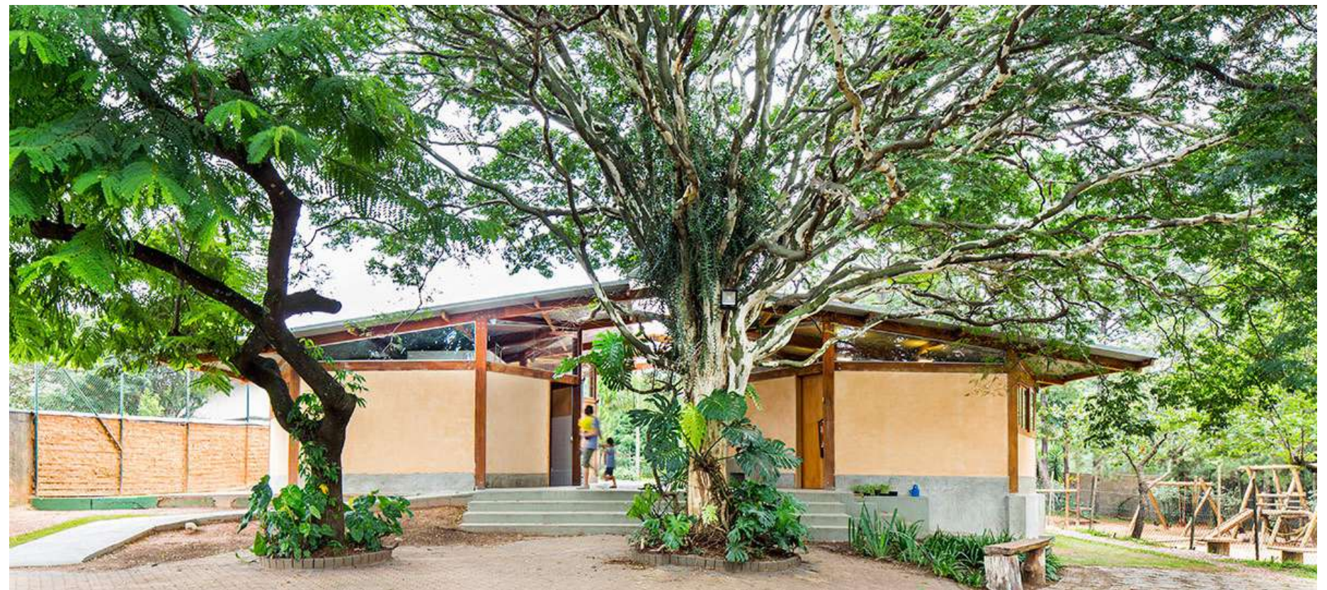
Figura 34 - Fachada Frontal da Escola Ecoara. Fonte: Archdaily, modificado pela autora, 2022.
